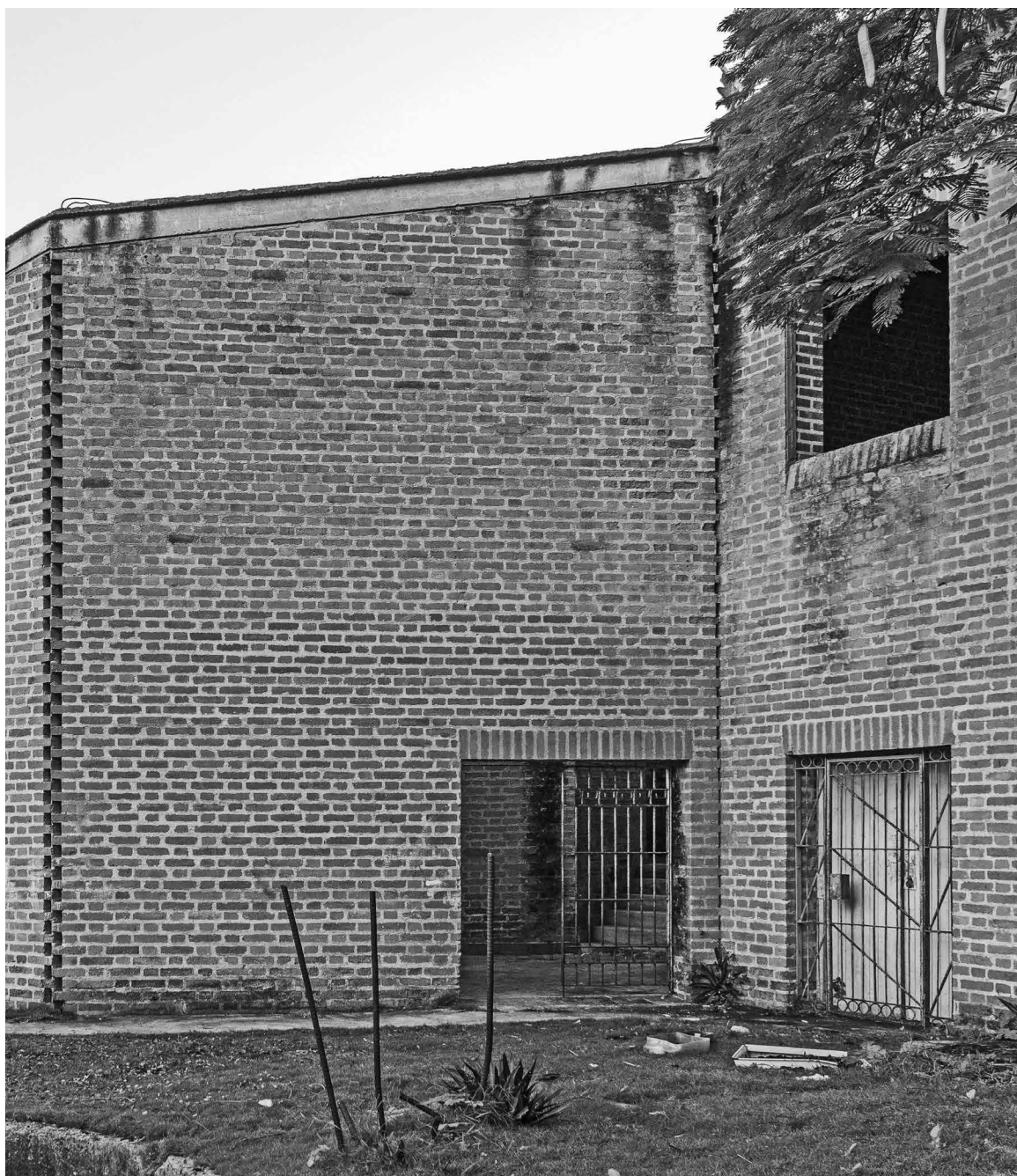
Fig. 25 | Alzado exterior del bloque 6 (créditos: CHM_Lab). | Prospetto esterno del blocco 6 (credits: CHM_Lab).
