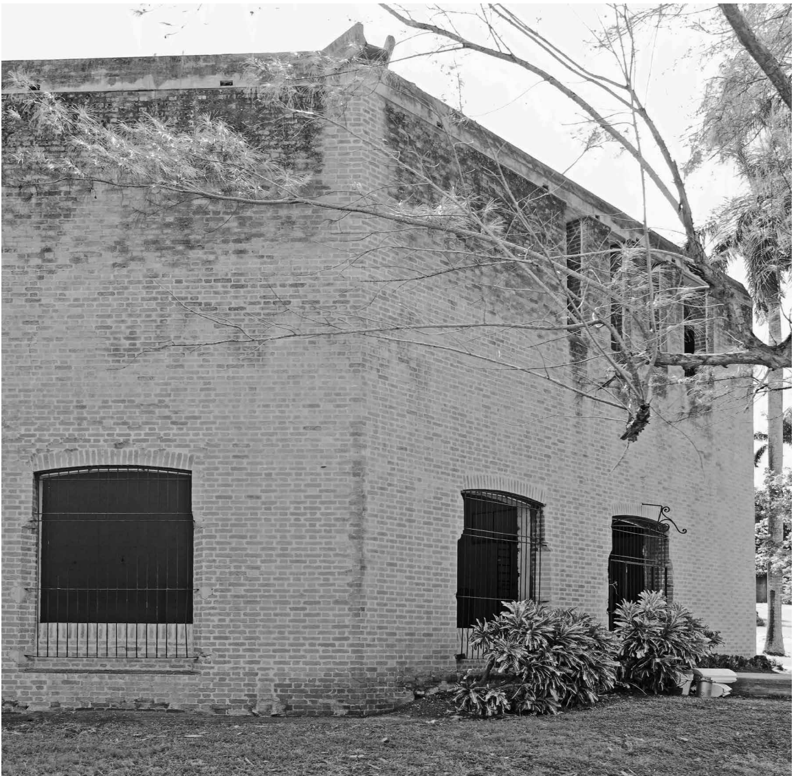
Fig. 17 | Alzado exterior del bloque 5. (créditos: CHM_Lab) | Prospetto esterno del blocco 5 (credits: CHM_Lab).
