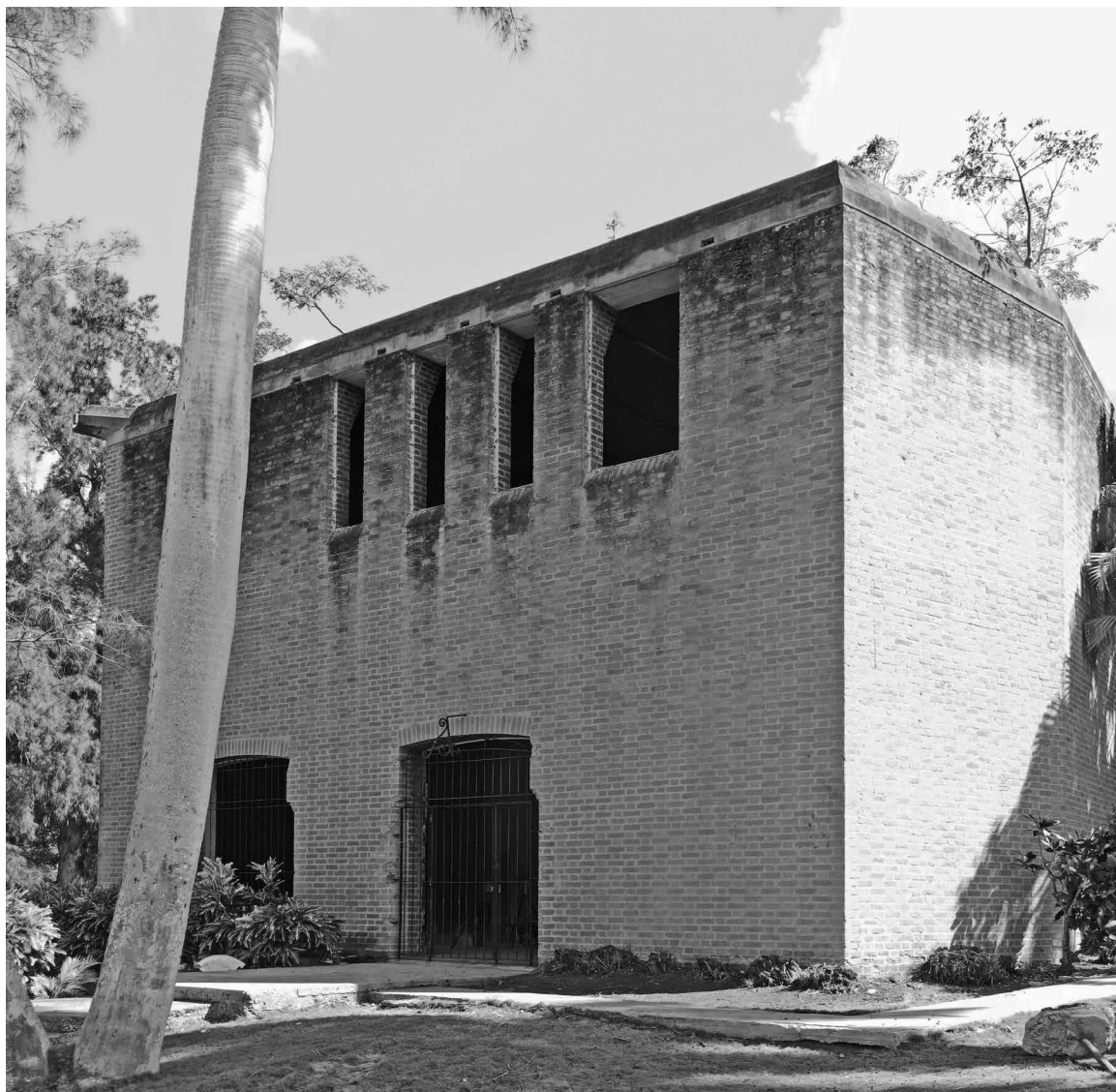
Fig. 18 | Alzado exterior del bloque 5 (créditos: CHM_Lab). | Prospetto esterno del blocco 5 (credits: CHM_Lab).
