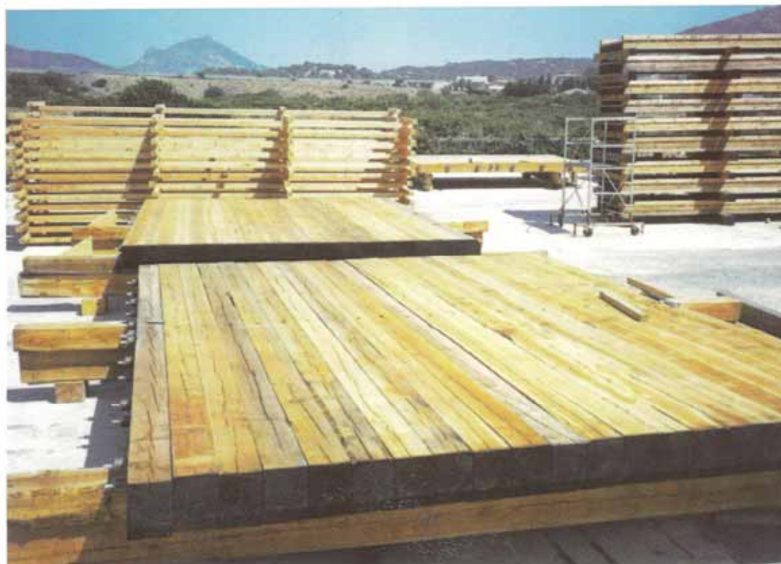
Figura 4. Impalcato di un ponte di II Cat. realizzato con travi di Larice classificate secondo la resistenza, solidarizzate lateralmente mediante tiranti di acciaio muniti di dispositivi elastici di recupero delle variazioni dimensionali del legno indotte dallo stato igrometrico del materiale.
