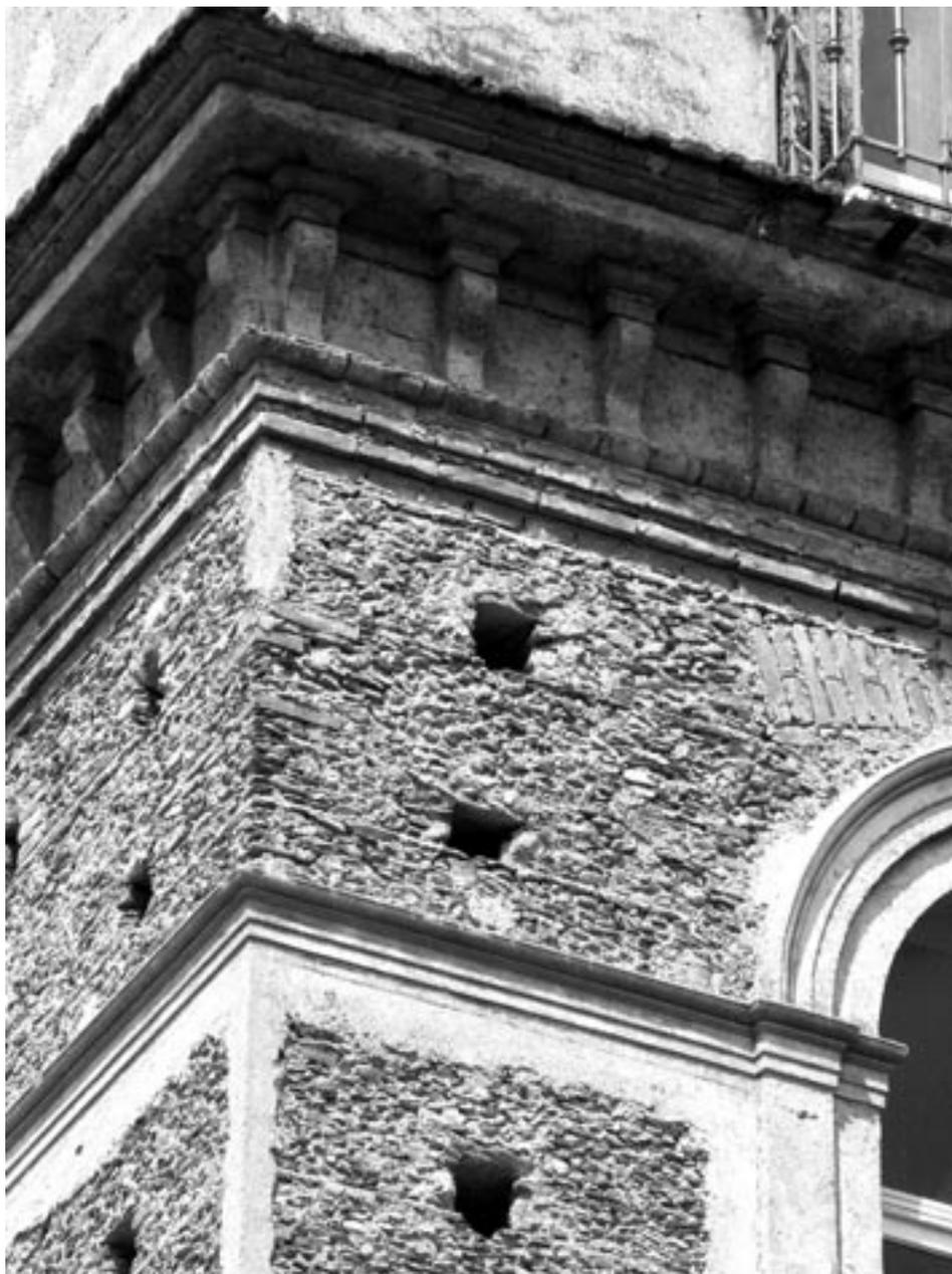
Fig. 2 – Edificio in Lamezia Terme, Italia, muratura “civata”.
