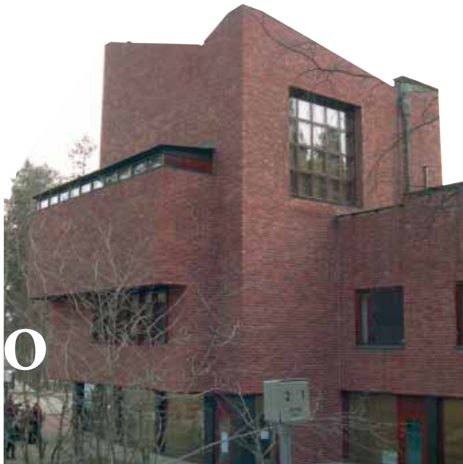
Vista dell'angolo nord est della sala consiliare.
