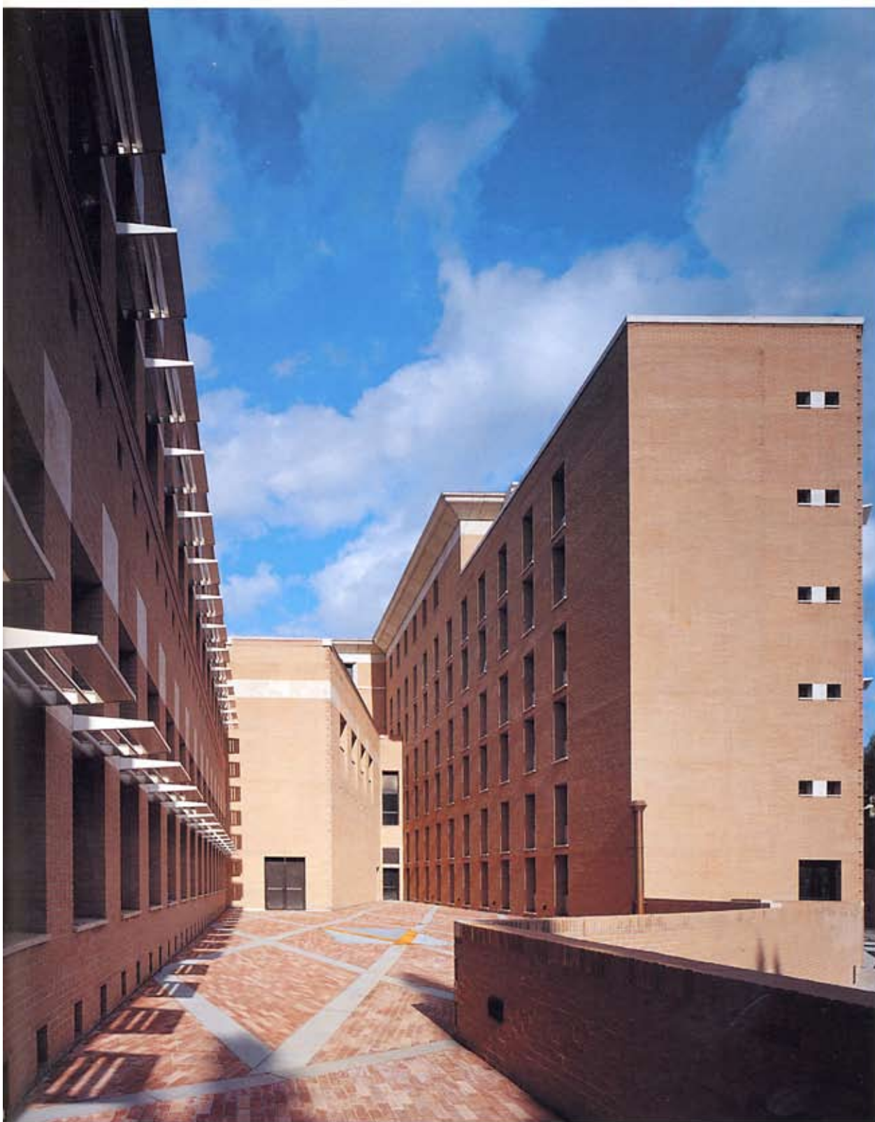
3. Veduta della corte compresa tra la bibliote- ca ed il corpo delle aule.
