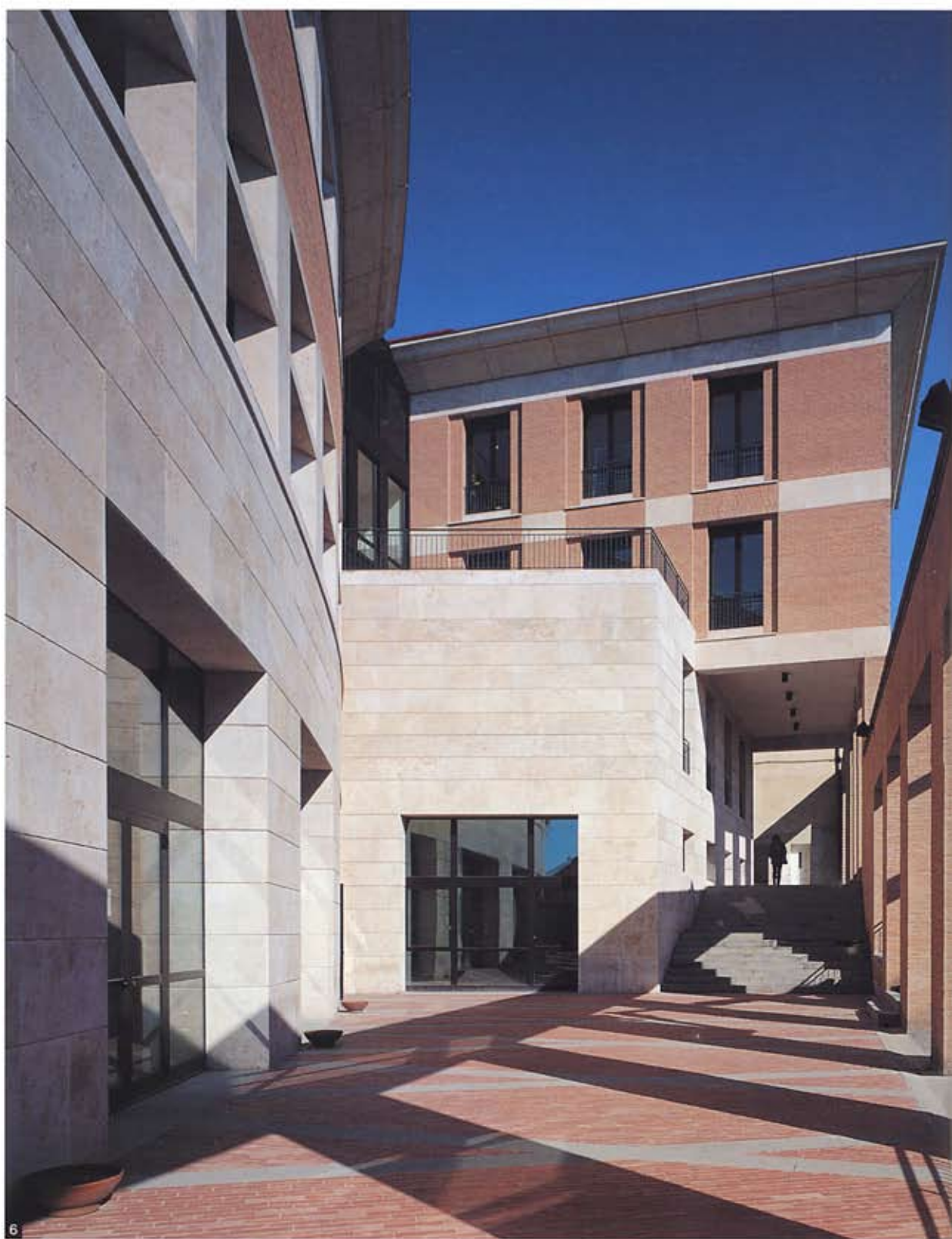
6. Veduta dello stargo di ingresso.
