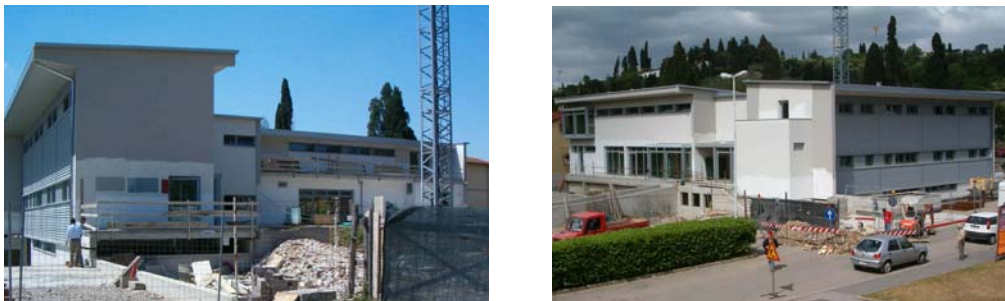
Figura 31. Viste d'insieme dell'edificio durante le fasi di finitura delle facciate.
