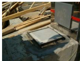
Figura 28. Posa in opera di un appoggio in acciaio-PTFE.
