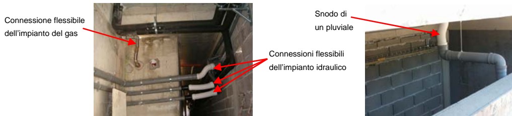
Figura 30. Dettagli impiantistici in corrispondenza dell'attraversamento dell'impalcato mobile.
