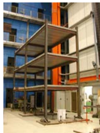
Figura 12. Vista del telaio in acciaio in scala 2:3 assunto a riferimento per la prova pseudodinamica con sottostrutturazione condotta nell'ambito del Progetto DISPASS.
