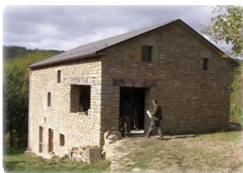
Figura 2. Poggio Gruffieto, esempio di casa di pendio.
