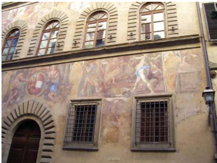
Pal. Mellini- Fossi (n. 43), particolare pitture murali restaurate
