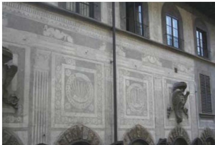
Palazzo n° 28, particolare del trattamento delle lacune
