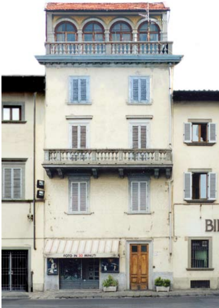
Piano del colore del centro storico di Prato (1999-2004), Casa Mazzanti, es. di restauro degli apparati decorativi e dei graffiti di facciata: a sinistra, la facciata in degrado, ancora coperta da scialbi pittorici a tempera; a destra, la stessa dopo l'intervento conservativo e di ripristino pittorico.
