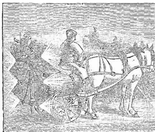
Fig. 214. — Pulvérisateur à traction sur roues basses avec lance verticale.
