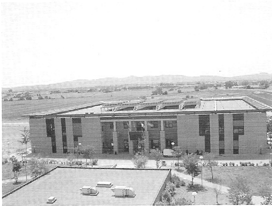
Fig. 13, 14, 15 Integrazione fotovoltaica per l'edificio aule e biblioteca al Polo Scientifico di Sesto Fiorentino (FI).
