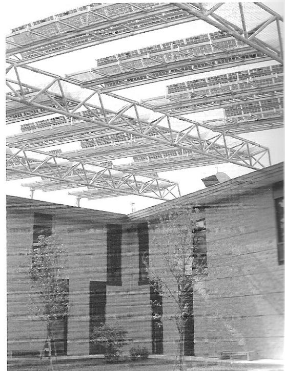
Fig. 13, 14, 15 Integrazione fotovoltaica per l'edificio aule e biblioteca al Polo Scientifico di Sesto Fiorentino (FI).
