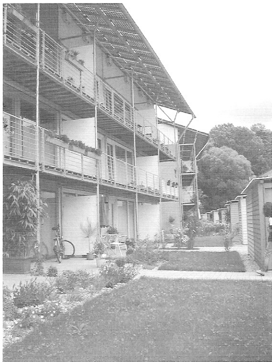
Fig.8- Residenze a Vauban, Friburgo, Germania - coperture fotovoltaiche in policristallino
