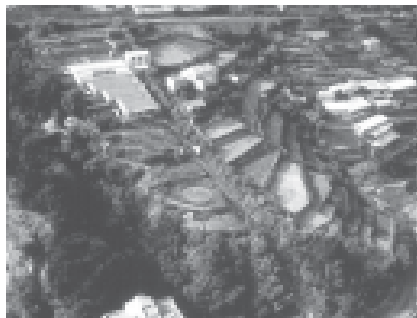
4.8 Sistemazione esterna del Workshop dell'UNESCO a Genova
