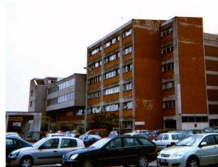
Figura 9. Immagini della facciata del Padiglione Chirurgia corrispondenti ai punti di vista A (in alto) e B in Figura 8
