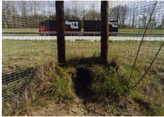
Esempio di varco realizzato per il passaggio di piccoli mammiferi sotto il manufatto stradale (www.iene.info)
