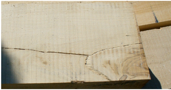
Fessurazione da ritiro (linea circa retta) lungo la direzione della fibratura, cipollatura che segue la linea curva degli anelli, non ammessa.
