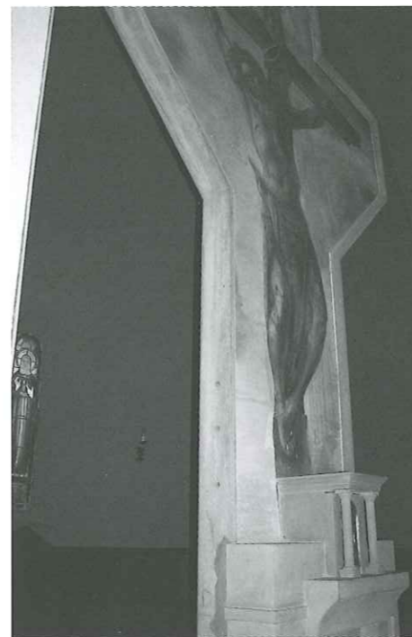
Fig. 10. Visione laterale della Crocifissione. Oltre ad apprezzare la natura e lo spessore del supporto di cemento armato, sono visibili, poco sopra l'altare, tre fori di aereazione. Un'altra serie di tre fori è visibile sul lato opposto, insieme ad altri fori visibili su entrambi i lati all'altezza del Titulus cruci (ripresa fotografica autorizzata dal parroco Don Bruno Brezzi).
