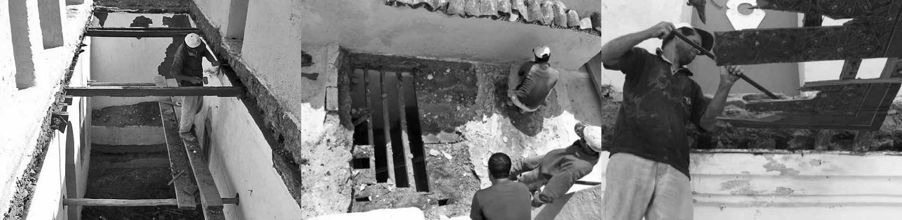
Rimozione degli antichi solai in legno
