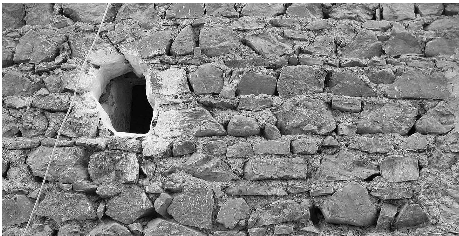
Muratura in pietra, tipo principale
