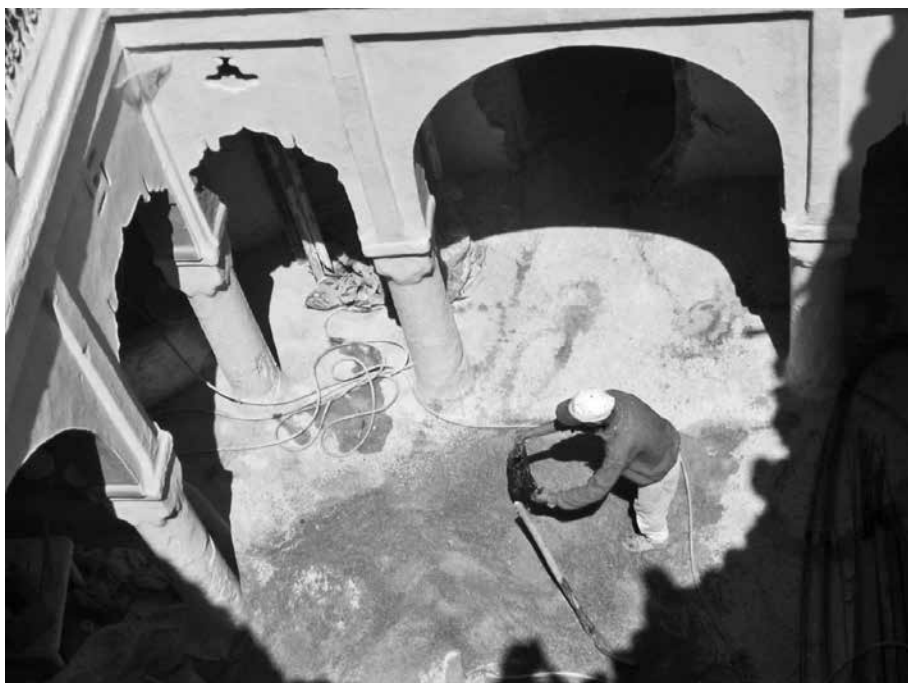
Cantiere di ristrutturazione in un edificio storico del quartiere Rif Al Andalous
