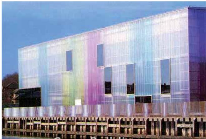
Fig. 3.27 Esempio di applicazione del sistema di isolamento trasparente.
