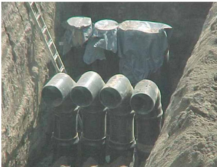
Fig. 3.32 Esempio di canalizzazioni sotterranee per la ventilazione.
