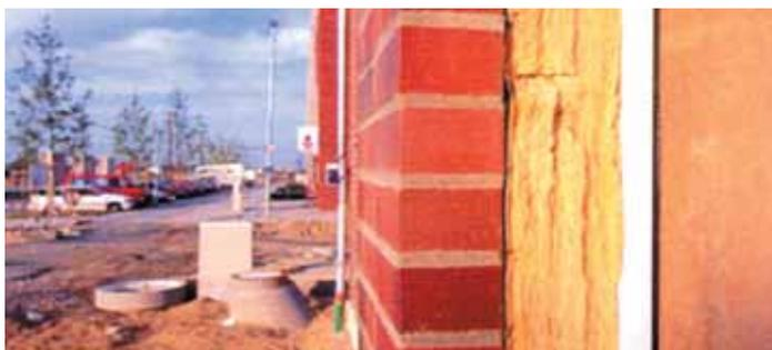
Fig. 3.9 Esempio di isolamento realizzato con materiali naturali.
