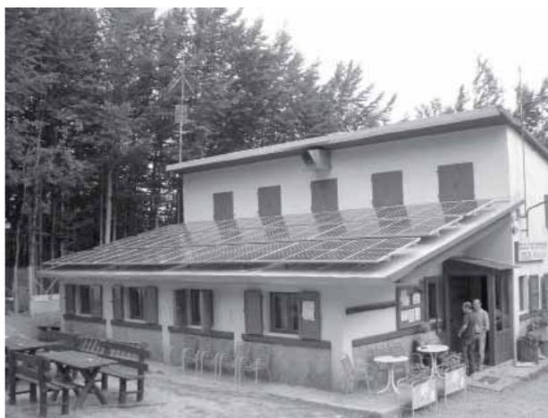
Fig. 3.24 Esempio di integrazione architettonica dei moduli fotovoltaici in copertura.
