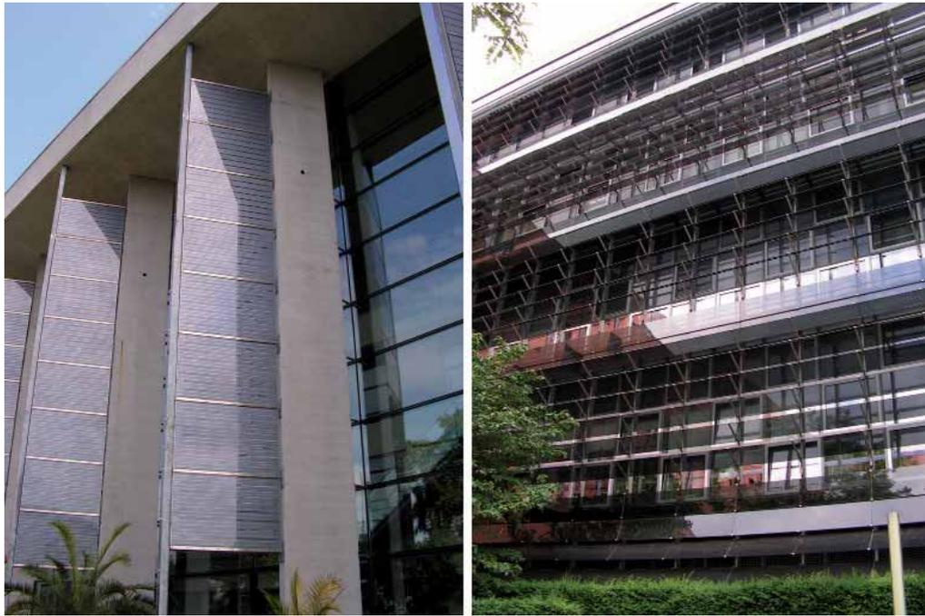
Fig. 3.39a – 3.39b Il sistema Shadovoltaic verticale ed orizzontale.
