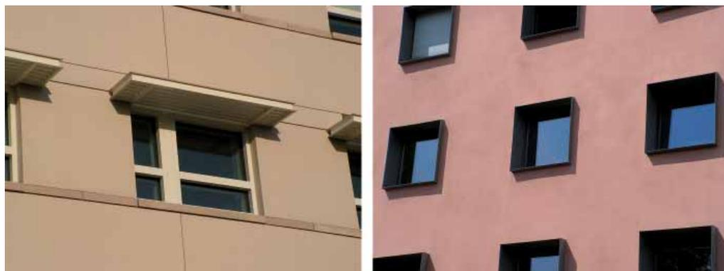
Fig. 3.35a – 3.35b Esempi di schermatura esterna fissa.
