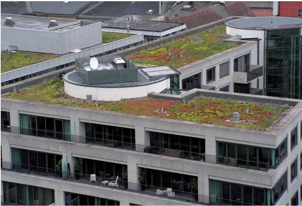
Fig. 3.14 Esempio di copertura a verde di tipo estensivo.
