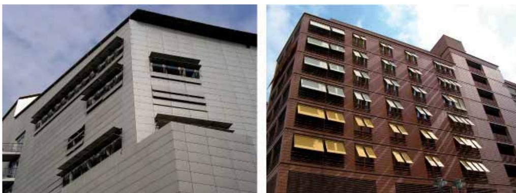
Fig. 3.38a – 3.38b L'elemento schermante integrato nell'involucro edilizio.
