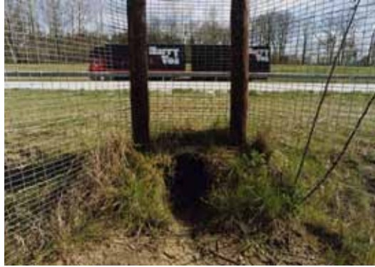
Esempio di varco realizzato per il passaggio di piccoli mammiferi sotto il manufatto stradale (www.iene.info)
