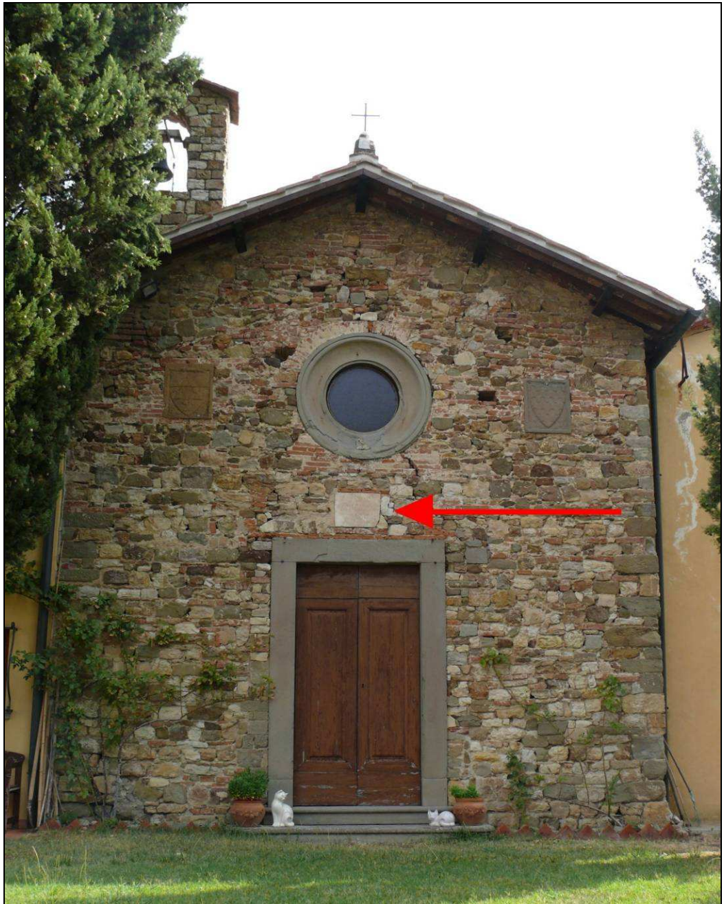
Figura 157 - Signa, Chiesa di S. Rocco - Collocazione dell'iscrizione in facciata (1287)
