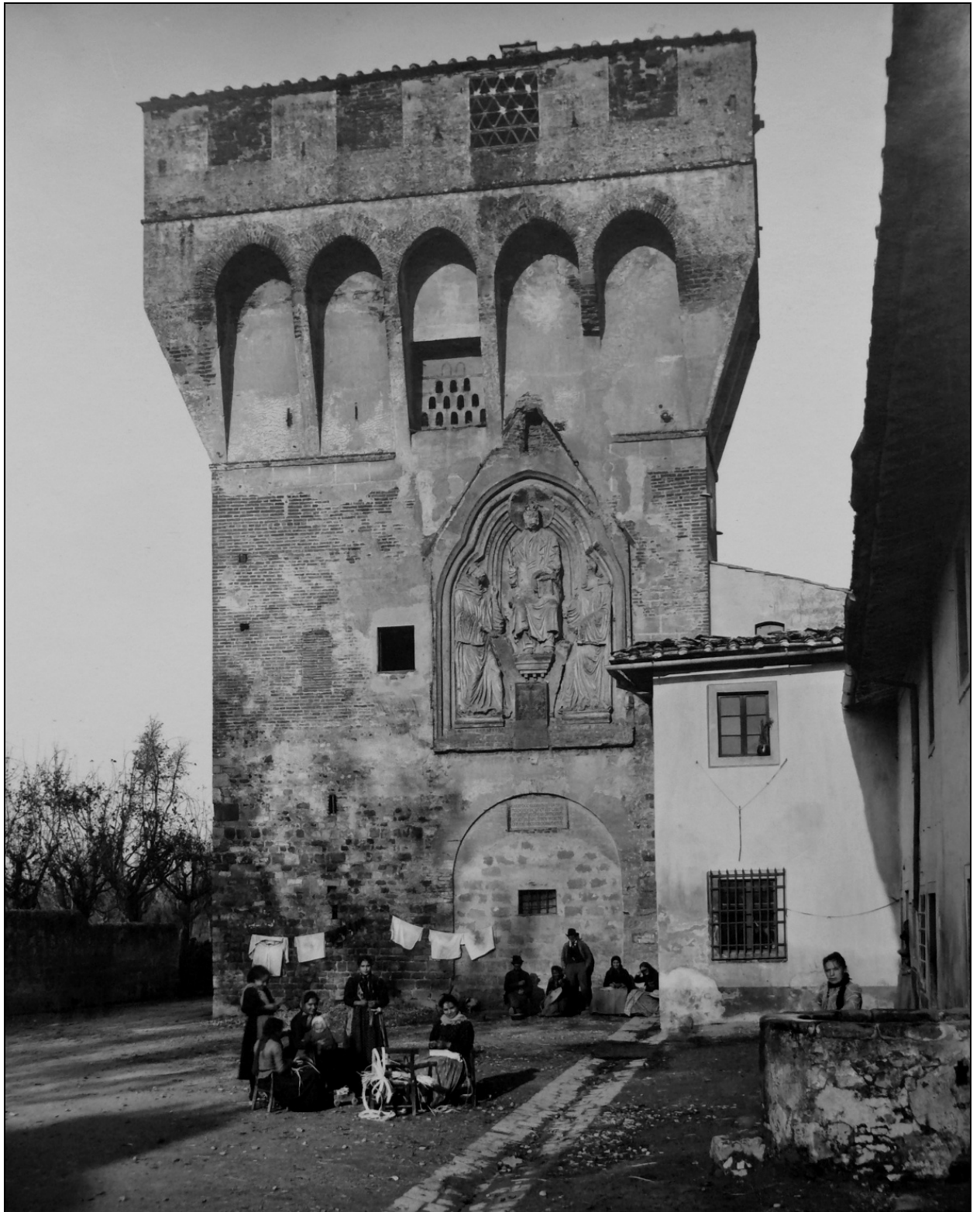
Figura 113 - Settimo, Abbazia di S. Salvatore - La torre del Colombaione prima della distruzione operata dai tedeschi
