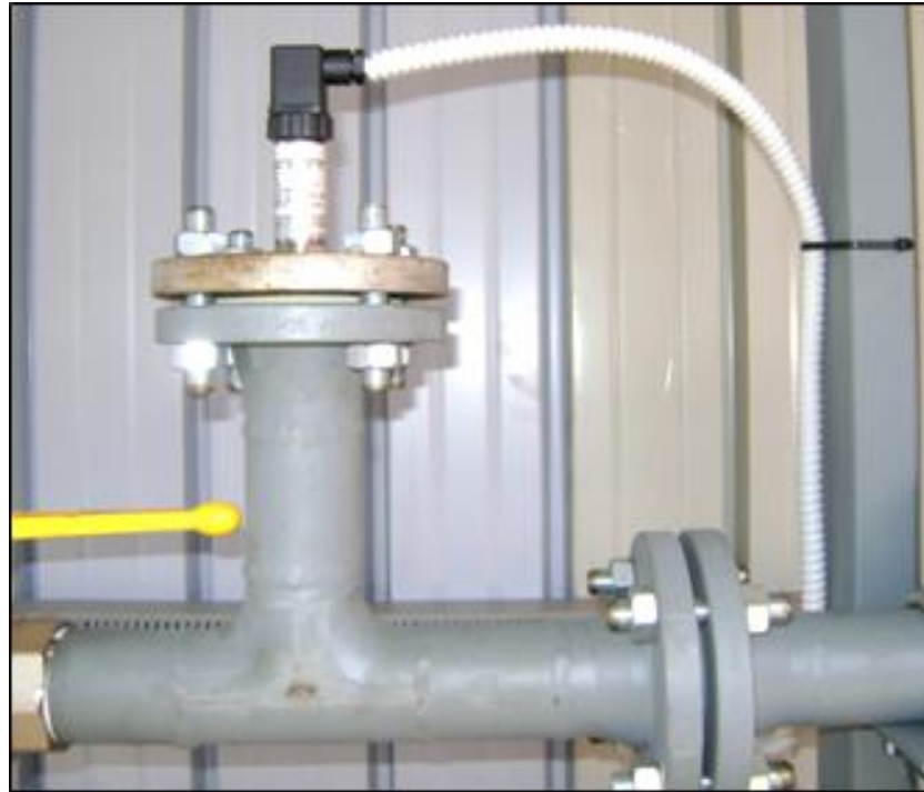
Figura 39: Installazione sensori di pressione lungo linea adduzione gas
