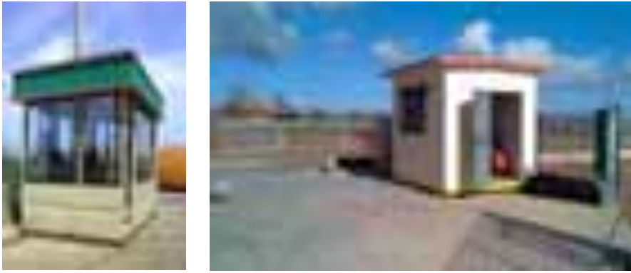
Figura 83: Foto del primo e del secondo locale di controllo dell'impianto
