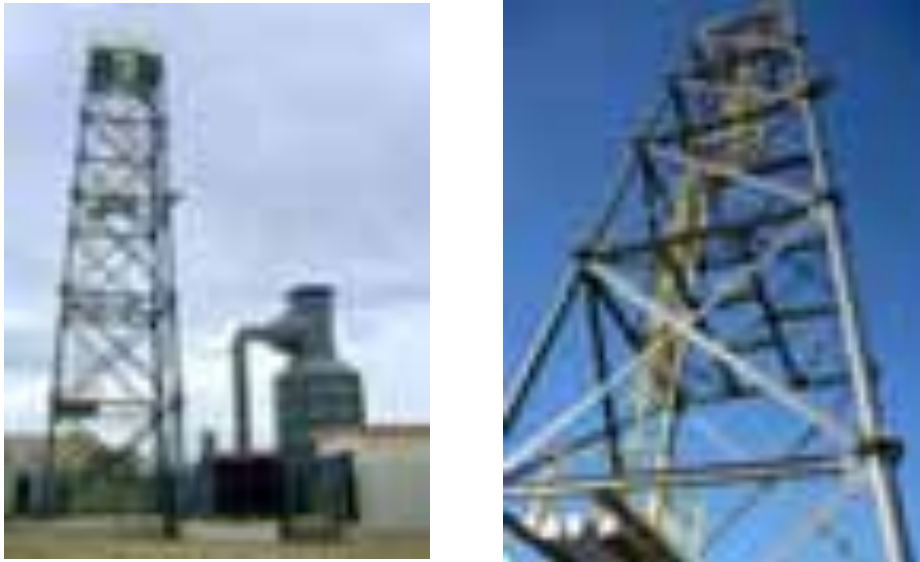
Figura 22: Foto dell'impianto e particolare dal basso del Derrick
