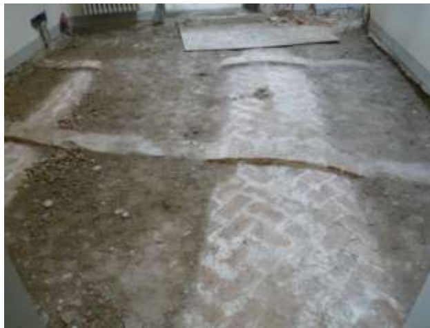
Tipologia di orizzontamento in opera. Trattasi di volta in foglio con frenelli di irrigidimento
