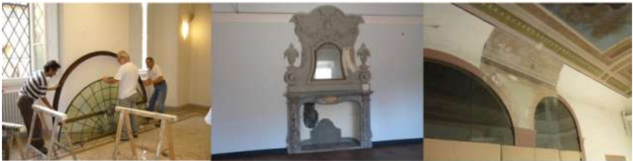
Montaggio del riquadro di vetri di grandi forme.
