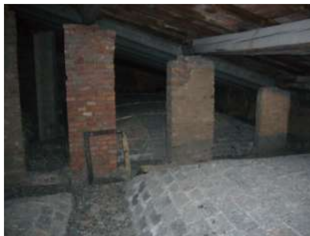
Stato esistente di una porzione di copertura in legno e estradosso di volte in foglio a padiglione
