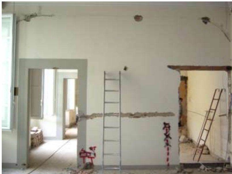
Parete di tamponamento esistente
