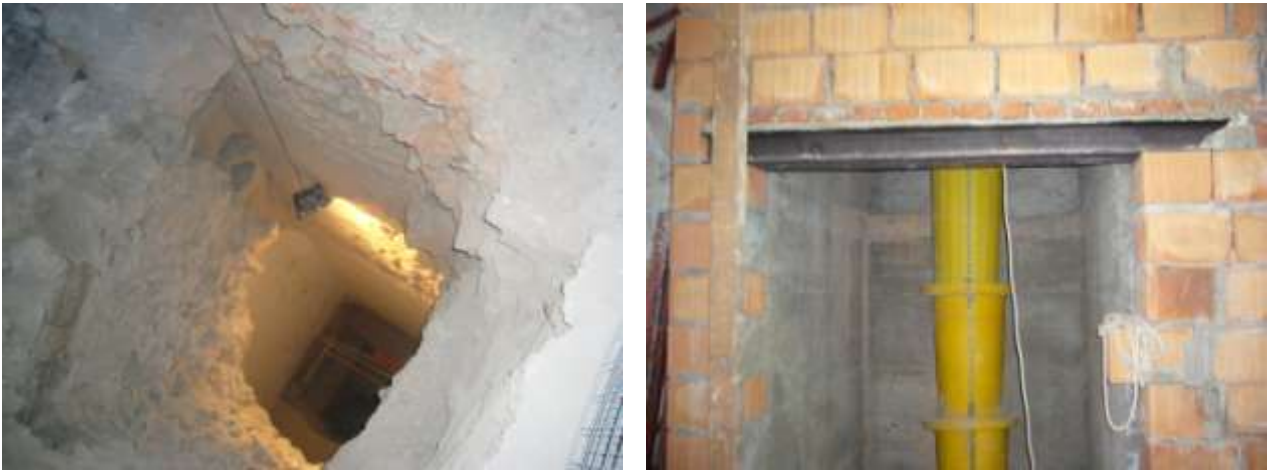
Localizzazione del vano ascensore e presa visione dello stato esistente e, a fianco, la profilatura delle pareti del vano ascensore e architravatura della porta di piano.
