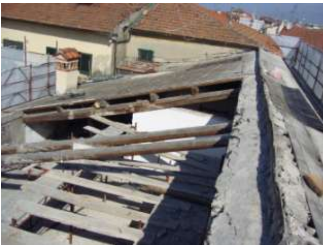
La copertura allo stato iniziale e la nuova struttura della copertura in acciaio e legno in fase di ultimazione
