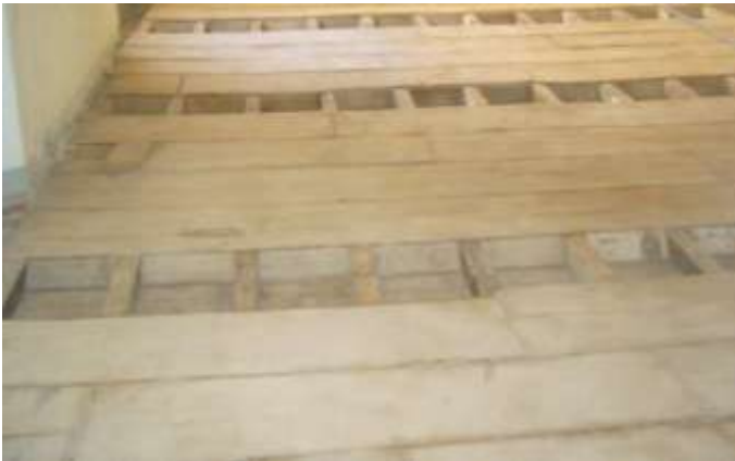
La struttura lignea del solaio esistente di piano secondo
