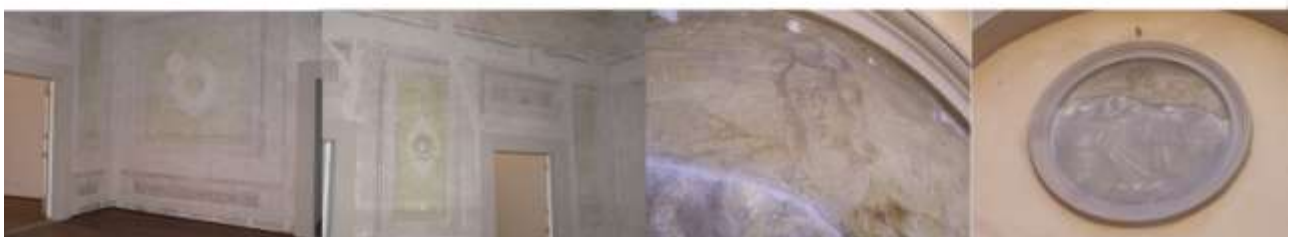
Palazzo Vaj, il restauro degli interni, fasi di lavoro con recupero di fregi pittorici antichi
