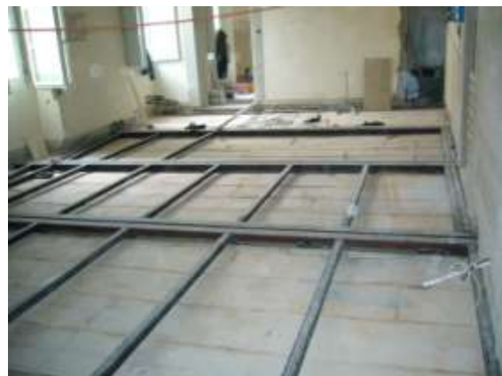
Lo svolgimento delle lavorazioni sul solaio esistente
