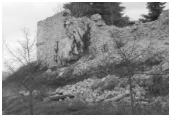
Le mura urbane dopo il terremoto dell'aprile 2009.
