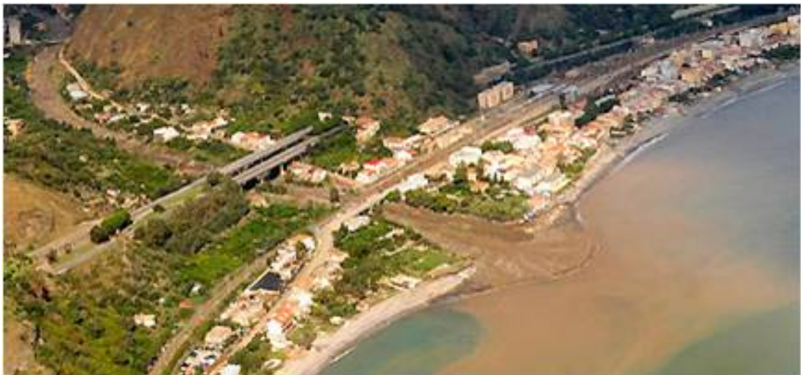
(b) Colata di detrito - Evento del 01 Ottobre 2009
