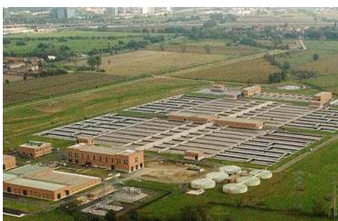
Figura 2.1.3 - Vista aerea dell'impianto di Nosedo
