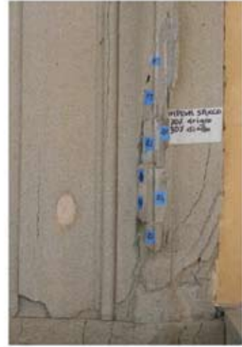
Consolidamento selettivo con stucco
