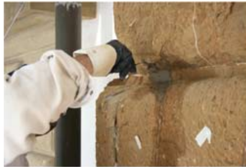
Preconsolidamento con applicazioni localizzate
