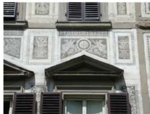
Chiaroscuro sgraffito: ricerca di effetti sfumati e tridimensionali con tecnica incisa a contrasto ed ausilio sul fresco di tinta messa a velatura
