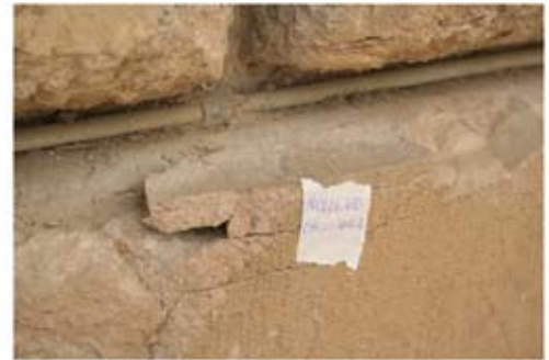
Consolidamento con resina epossidica
