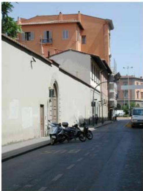
Applicazioni di tinta deviata (edificio color albicocca) ed effetto disordinato a toppe sulla parete imbrattata da scritte graffite
