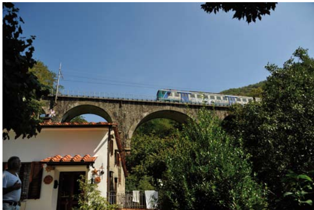
Figura 4 Viadotto ferroviario di San Mommè; in primo piano il mulino Diddi (DSC2238-2239- 2240)
