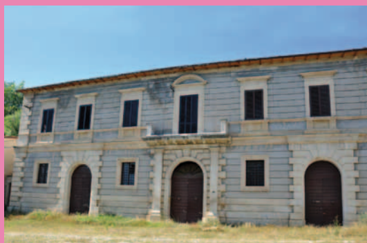
Terremoto del 6 aprile 2009. Castelnuovo delle Camere (AQ). Edificio privo di danni: esempio di costruzione secondo le "regole dell'arte".
