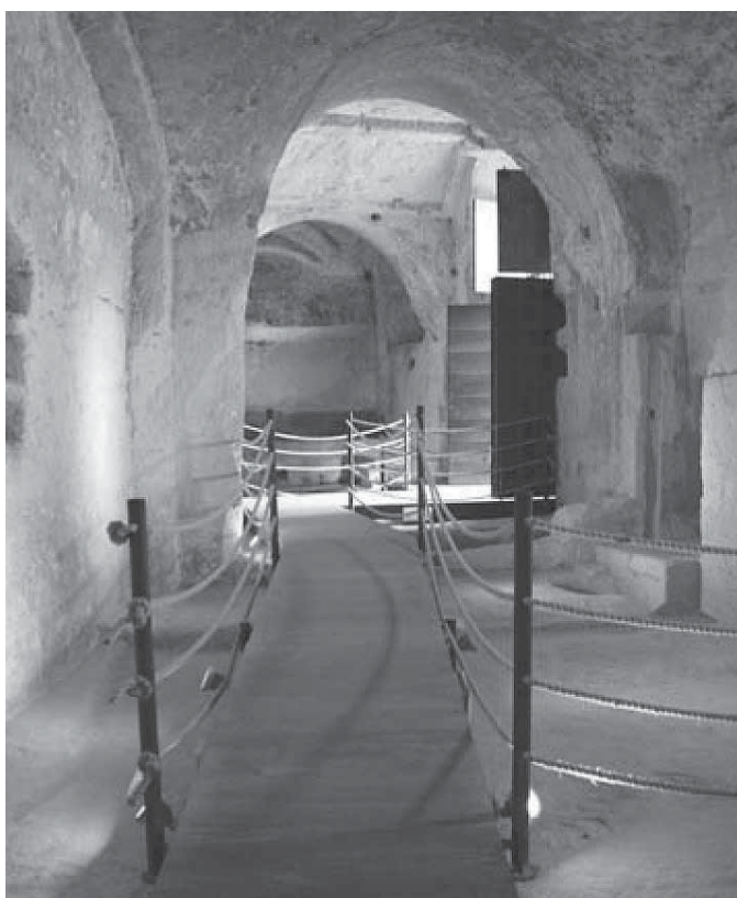
Fig. 3. Matera. Sasso Caveoso. Passerelle all'interno del Convicinio di Sant'Antonio
