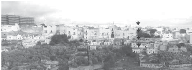
Fig.14: Unico ingresso di due unità contigue dell'insediamento rinascimentale
