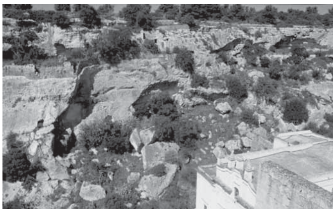
Fig. 2. Esempi di dissesti lungo le pareti della gravina Madonna della Scala a Massafra (Taranto): i crolli coinvolgono direttamente numerose cavità artificiali, scavate a più livelli sui fianchi della gravina.
