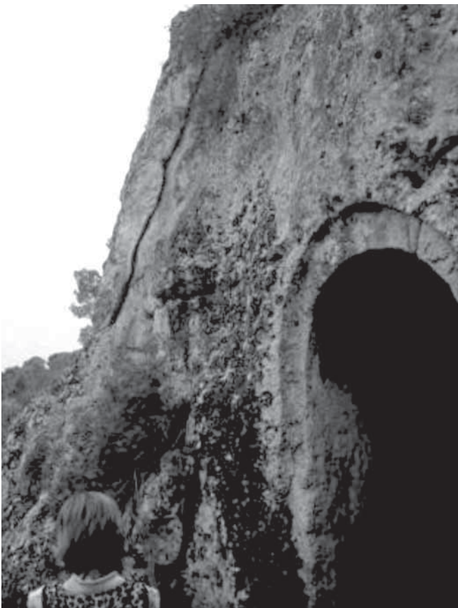
Fig. 4. Evidenti fratture in cavità artificiali: a sinistra, una parete della Chiesa Rupestre della Candelora (PU/CA 301) a Massafra; le altre due immagini riguardano cavità all'interno della Gravina di Petruscio, in territorio di Mottola.
