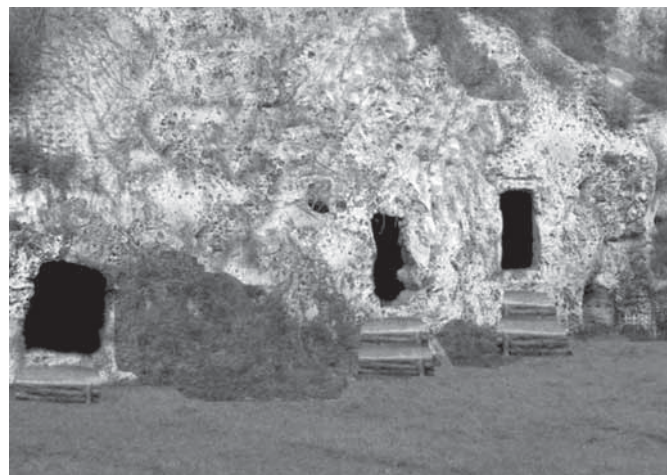
Fig. 4. Sistemazione del livello di calpestio e accesso alle grotte con scalette in legno e terreno stabilizzato
