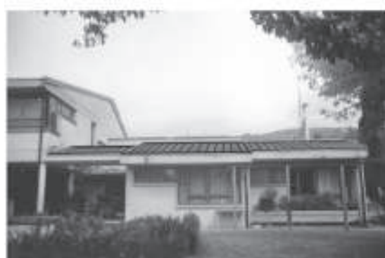
VISTA DOPO L'INSERIMENTO DEI PANNELLI
