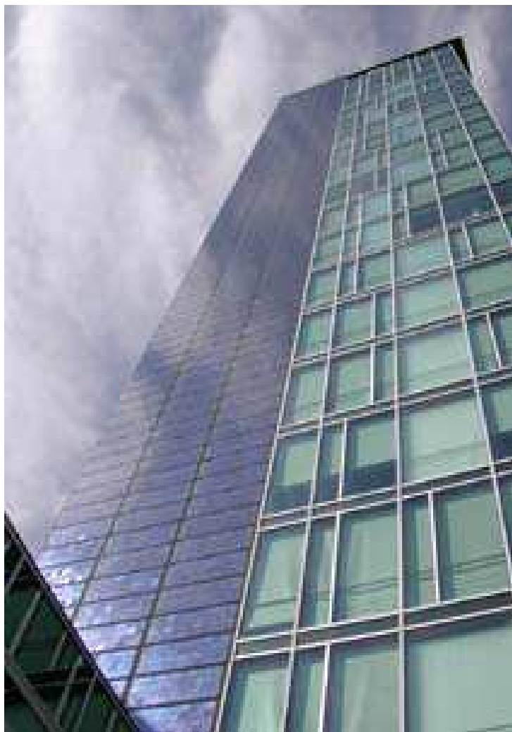
Torre della stazione - Friburgo, Germania
