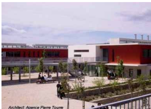
Vista del cortile.
