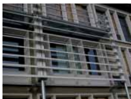
Particolare dei frangisole.
