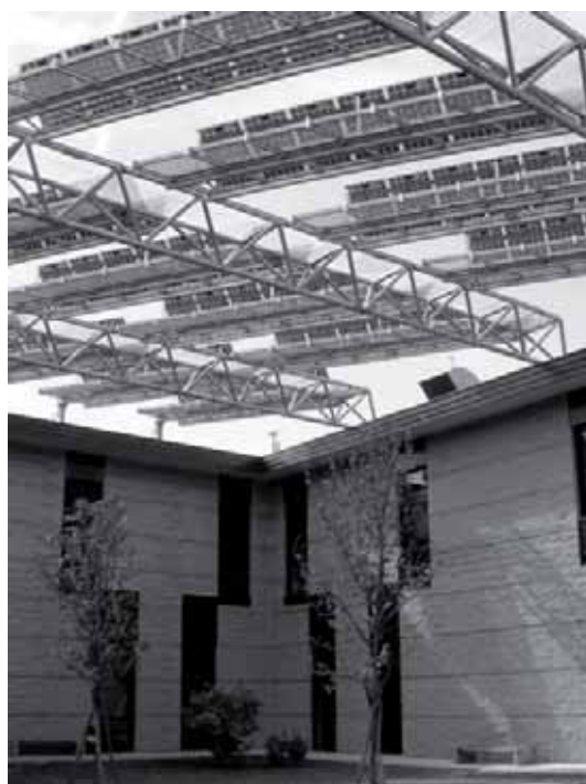
Fig. 3.25 Integrazione di un sistema fotovoltaico per la copertura di una corte interna.
