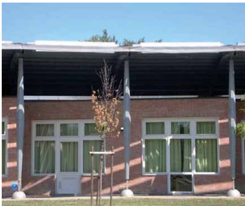
Facciata sud con finestre intelligenti.
