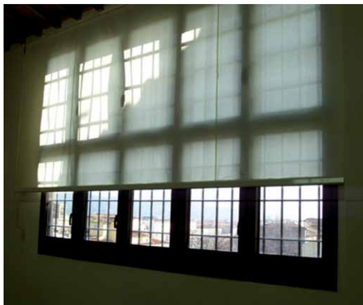
Controllo della radiazione solare per le finestre poste all'ultimo livello.
