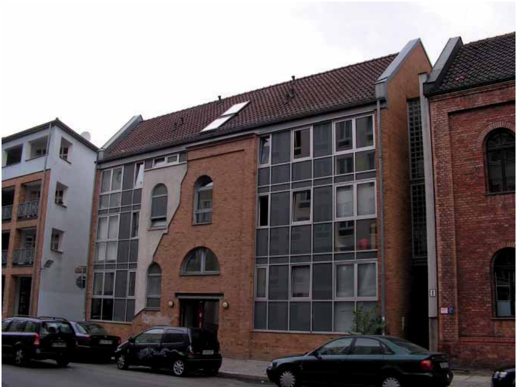
Fig. 3.1 Esempio di recupero di un edificio residenziale a Berlino.
