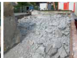
I materiali in fase di demolizione vengono separati.
