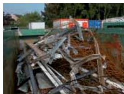
I materiali in fase di demolizione vengono separati.
