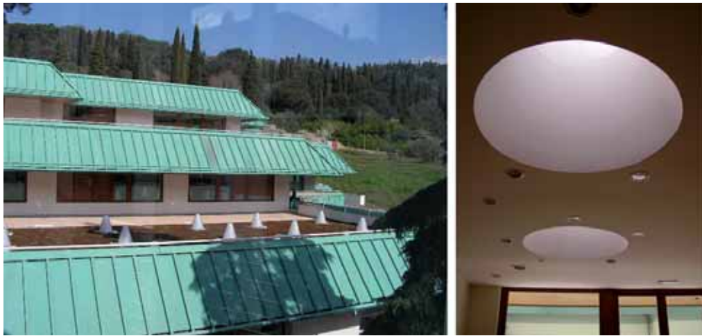
I condotti solari: le cupole sul tetto verde e i diffusori di luce all'interno dell'edificio.
