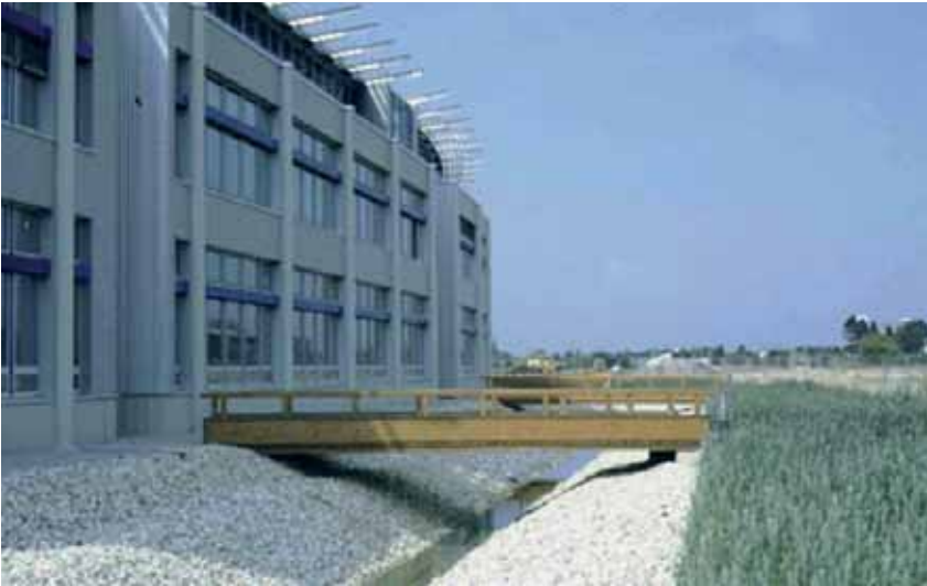
Fossato per acqua piovana.
