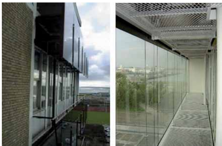
Particolari della facciata, prima e dopo la riqualificazione.
