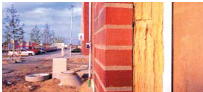
Fig. 3.9 Esempio di isolamento realizzato con materiali naturali.
