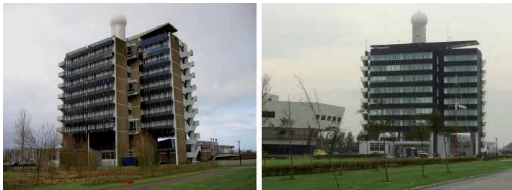
L'edificio Albatros prima e dopo la riqualificazione.
