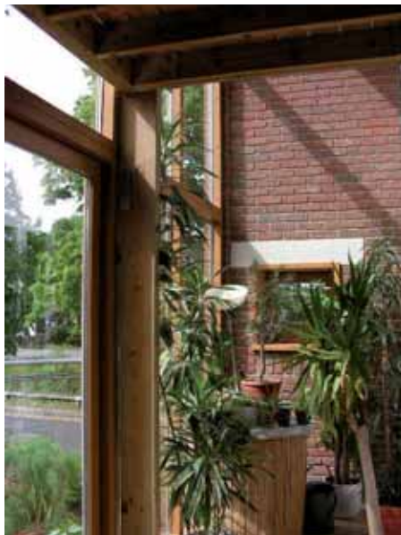
Fig. 3.21 La serra come spazio abitabile in cui la presenza di vegetazione può contribuire ad assicurare elevate condizioni di comfort.
