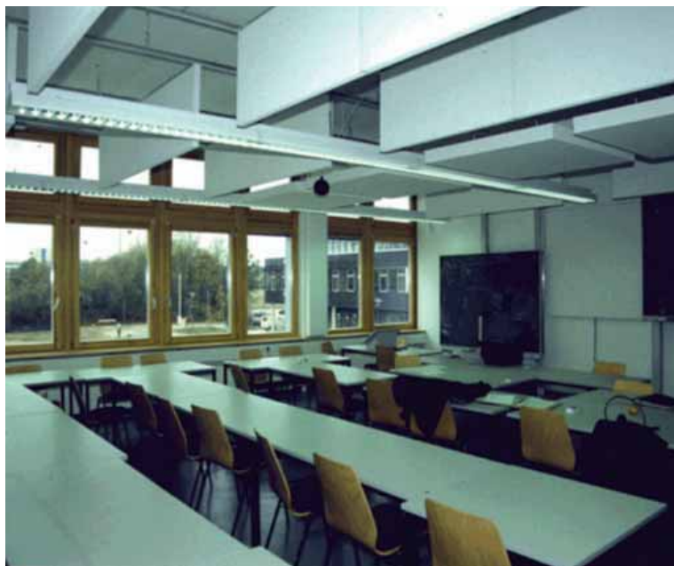
Muro non isolato e pannello acustico a soffitto.
