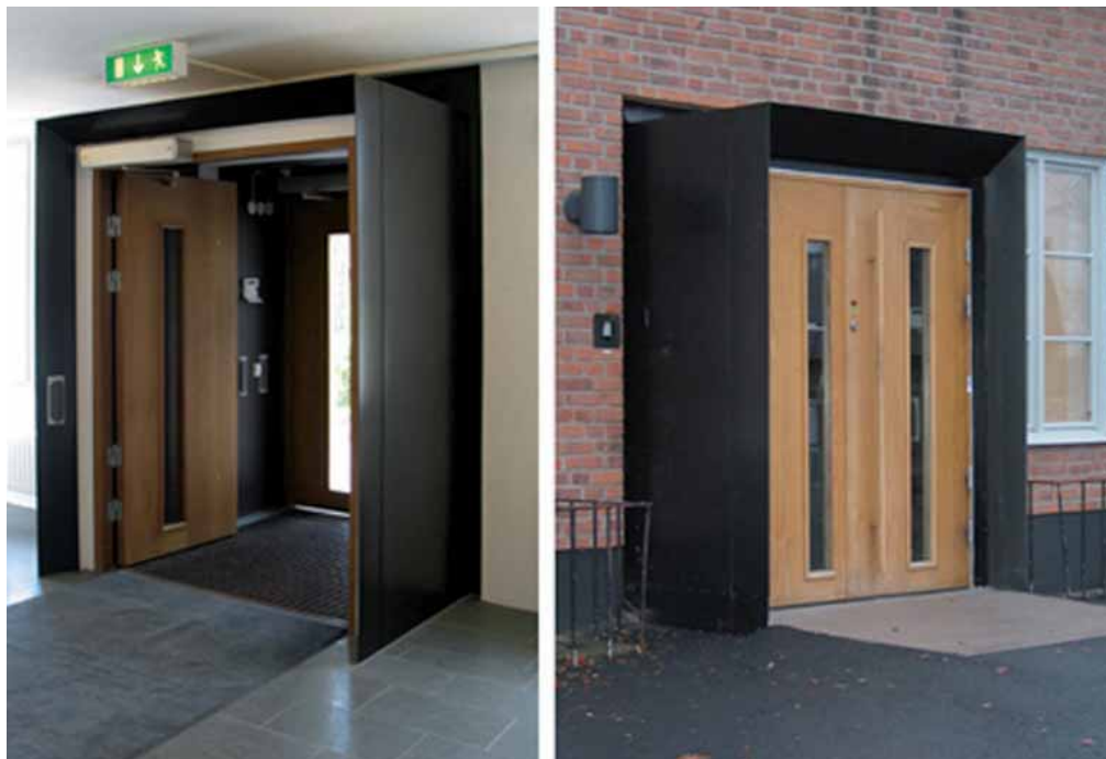
Air lock ingresso principale.
