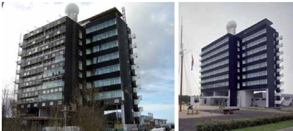
Le fasi di montaggio della double-skin.
