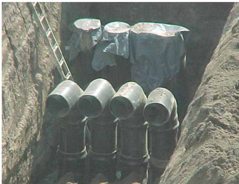
Fig. 3.32 Esempio di canalizzazioni sotterranee per la ventilazione.
