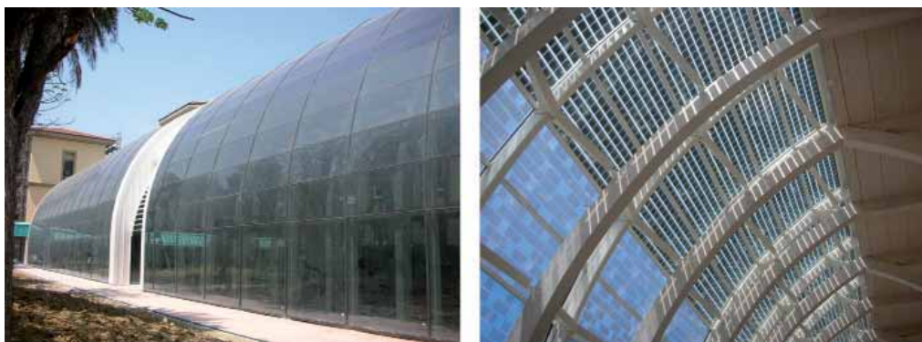
Fig. 3.15a – 3.15b Esempio di integrazione architettonica – La serra fotovoltaica dell'ospedale A. Meyer di Firenze.
