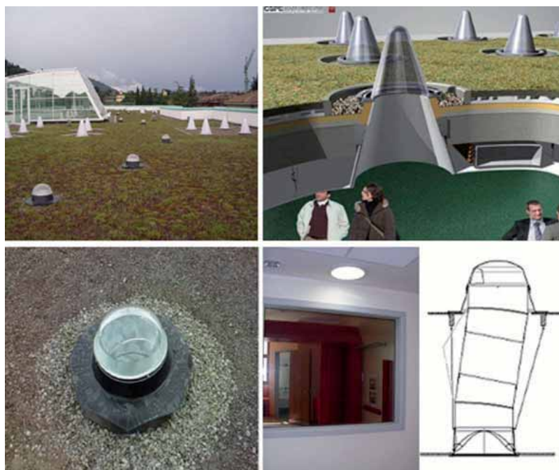
Fig. 3.50 I camini solari utilizzati nell’ospedale pediatrico A. Meyer di Firenze.
