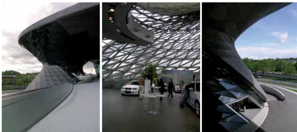
Fig. 3.7a – 3.7b – 3.7c BMW Welt, COOP HIMMELB(L)AU, Monaco, Germania, 2007. Nella doppia pelle dell'edificio è integrato un sistema di tubi radianti che provvedono al suo riscaldamento e raffreddamento.
