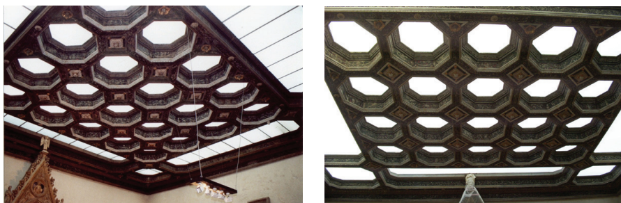
Fig. 8 – Il cassettonato prima dell'intervento con le formelle di vetro e dopo l'intervento con l'inserimento del telo preformato tipo Barrisol
