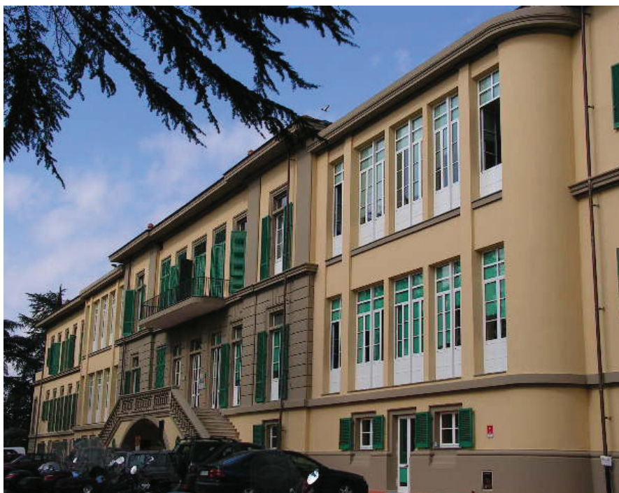
Fig. 14 –La nuova facciata dell’edificio recuperato
