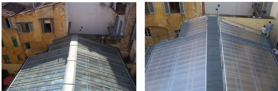
Fig. 9 – il lucernario prima e dopo l'intervento
