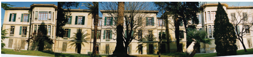
Fig. 11 – Vista della Villa Ognissanti prima dell'intervento di recupero
