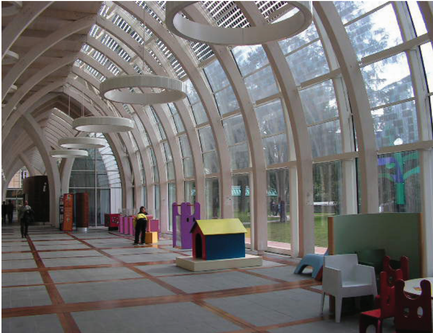
Fig. 16 – Interno della serra fotovoltaica
