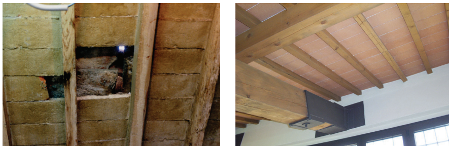
Fig. 2 – La copertura prima e dopo l'intervento
