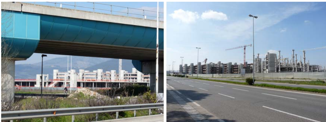
Fig. 5 Firenze, Viale XI agosto con il viadotto ferroviario e il cantiere della Scuola sottufficiali Carabinieri (marzo 2010)
