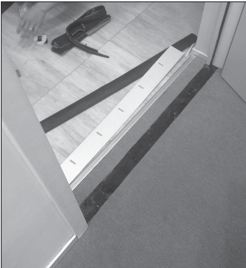
Fig. 16 – Guarnizione di tenuta sulla soglia
