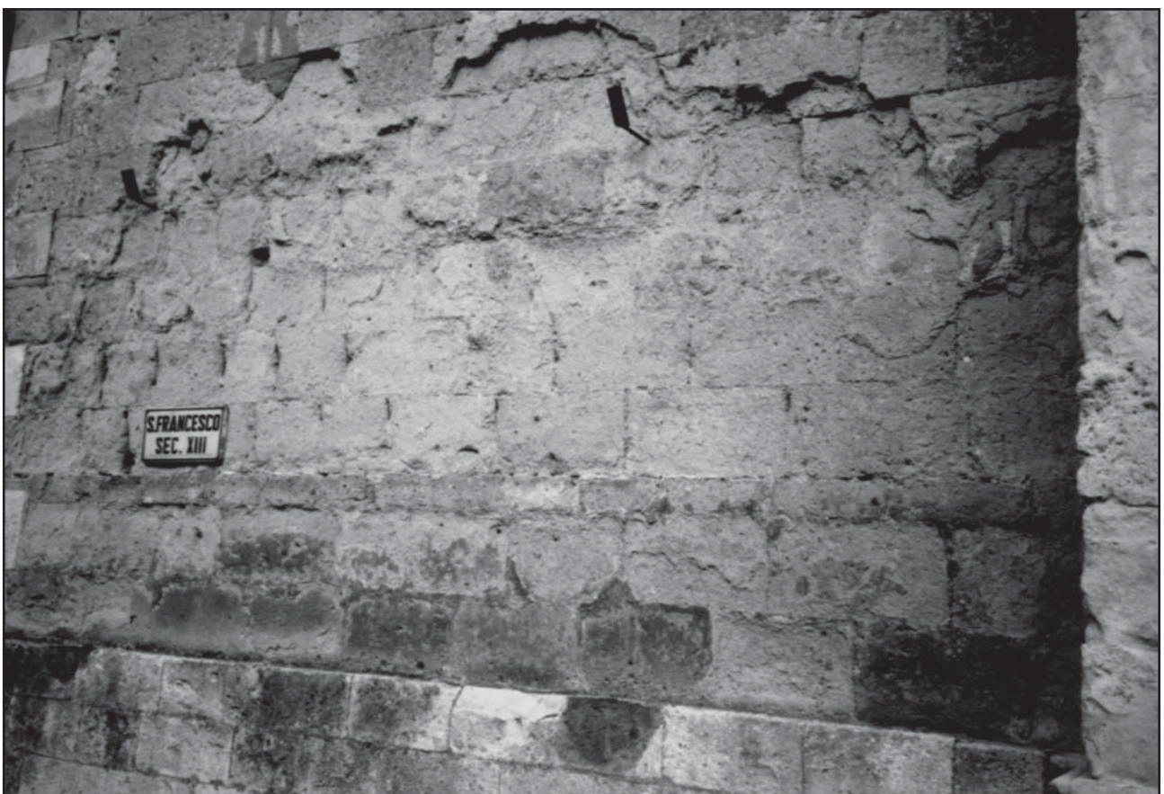
Fig. 3-4-5 – Efflorescenze esterne e sub-efflorescenze interne di cristalli di sali solubili trasportati nel muro da acqua in risalita che è evaporata dalla superficie del muro.
