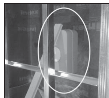
Fig. 8 – Foro con silenziatore da D_{new}=54\text{ dB}
