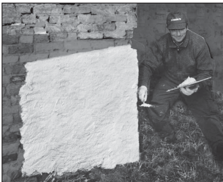
Fig. 8 - Posa a mano o a spruzzo dell’impacco di cellulosa modificata.
