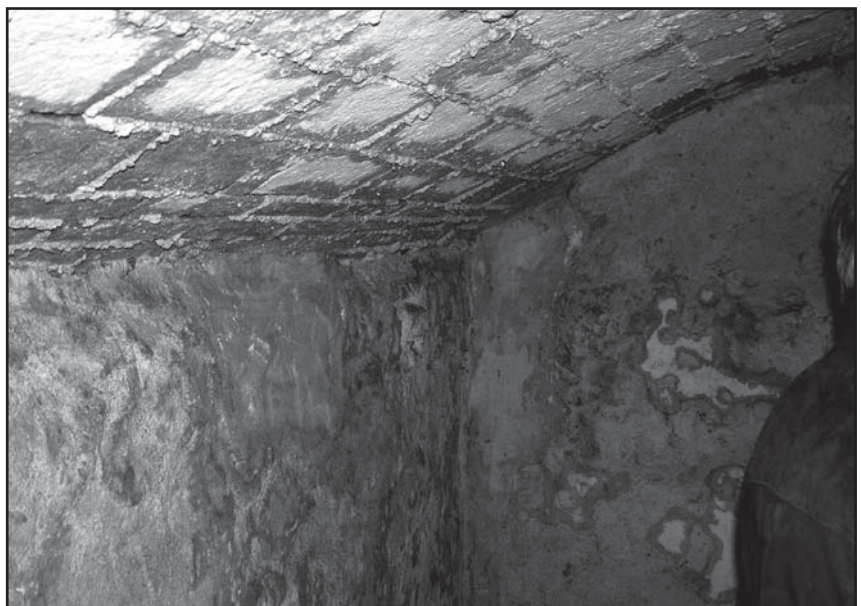
Fig. 6-7 – Efflorescenze visibili e sub-efflorescenze invisibili in intonaci. I cristalli dei sali solubili si sono formati a cavallo della superficie evaporante. I sali sono stati trasportati nel muro e poi nell’intonaco da infiltrazioni laterali di acqua (Fig. 6) e da risalita (Fig. 7).
