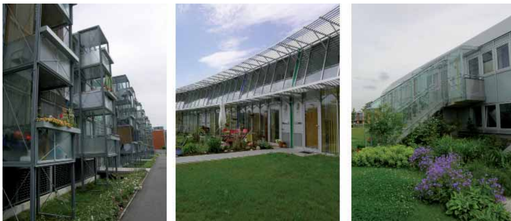
Fig. 3.5a – 3.5b – 3.5c Gli edifici del complesso residenziale Solar City Linz, Austria, 1996-2006, caratterizzati da un involucro iperisolato (Norman Foster, Richard Rogers, Thomas Herzog e Renzo Piano Building Workshop in qualità di consulente del gruppo progettuale).
