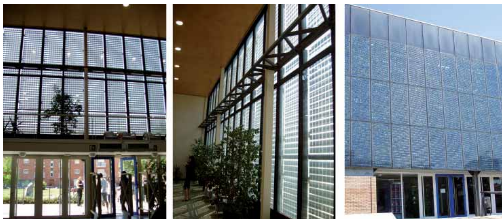
Fig. 3.6a – 3.6b – 3.6c La facciata fotovoltaica in pannelli di silicio policristallino semitrasparente della Biblioteca Pubblica Pompeu Fabra, Miquel Brullet Matarò, Barcellona, Spagna.
