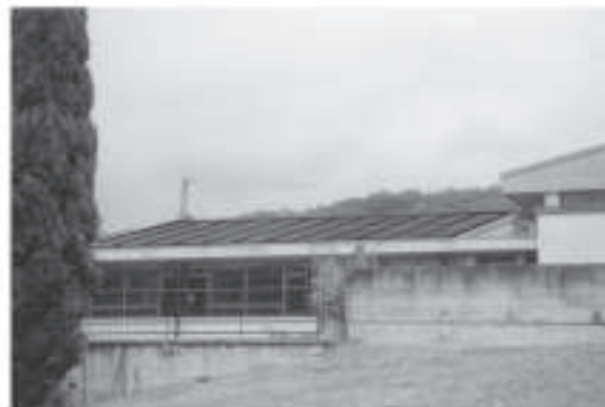
VISTA DOPO L'INSERIMENTO DEI PANNELLI
