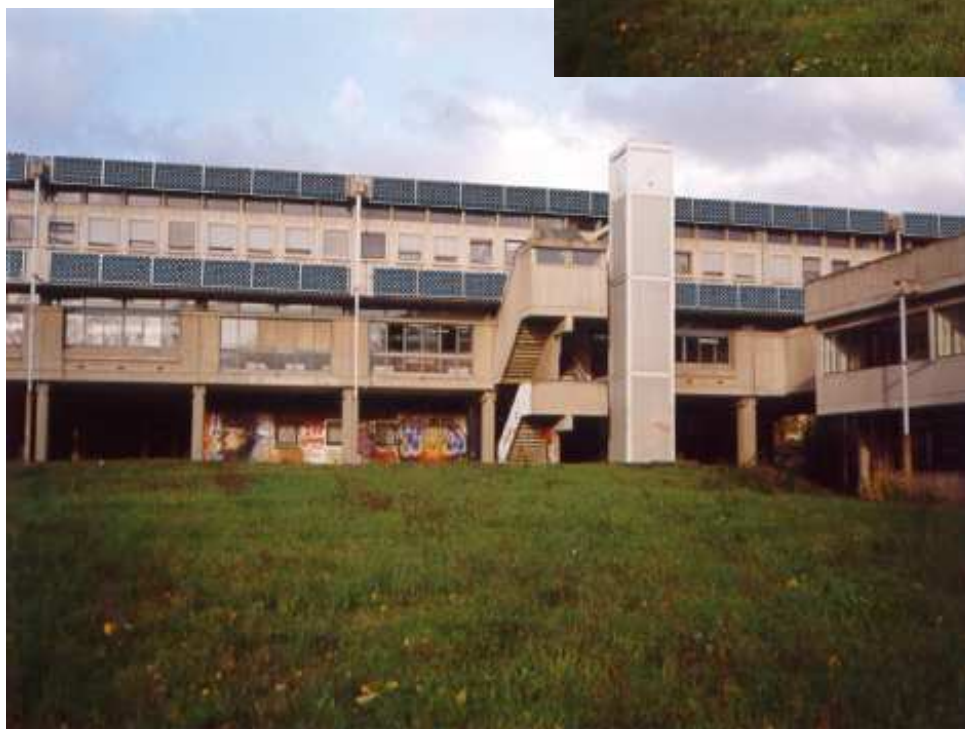
In alto: fotografia dello stato di fatto.
