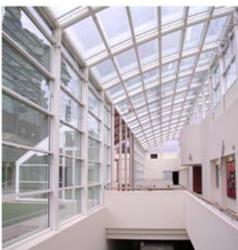
tecniche per favorire la ventilazione naturale in modo tale da utilizzare il meno possibile, e solo se necessario, l'impianto di raffrescamento. La serra svolge la funzione di spazio cuscinetto per l'intero edificio. L'aria riscaldata viene utilizzata per creare un flusso d'aria naturale che attraversa l'edificio.
