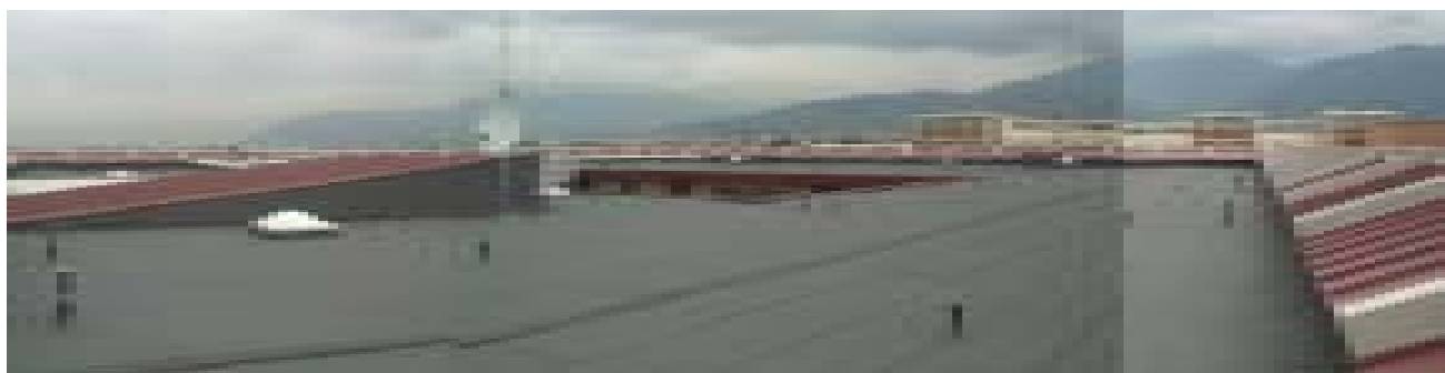
3 Copertura e area di installazione dei moduli
