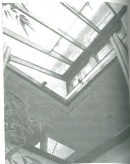
Fig. 33. Integrazione architettonica di un lucernario: miglioramento delle condizioni di comfort termico e visivo negli ambienti interni
