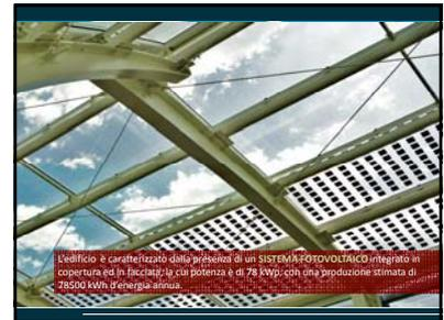
L'edificio è caratterizzato dalla presenza di un **SISTEMA FOTVOLTAICO** integrato di copertura ed in facciata, la cui potenza è di **78 kWp**, con una produzione stimata di **78500 kWh** d'energia annua.
