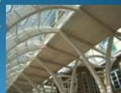
I laminati FV (di dimensioni 220 x100 cm) sono disposti su file parallele, sorretti dal corrente principale dell'itrasso lungo l'asse verticale e collegati orizzontalmente mediante i traversi della struttura, collocati nell'intradosso della serra, per garantire una continuità e compositiva strutturale della superficie vetrata nella parte esterna.
