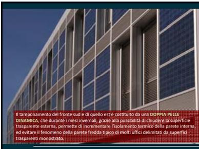
Il tamponamento del fronte sud e di quello est è costituito da una **DOPPIA PELLE DINAMICA**, che durante i mesi invernali, grazie alla possibilità di chiudere la superficie trasparente esterna, permette di incrementare l'isolamento termico della parete interna, ed evitare il fenomeno della parete fredda tipico di molti uffici delimitati da superfici trasparenti monostrato.
