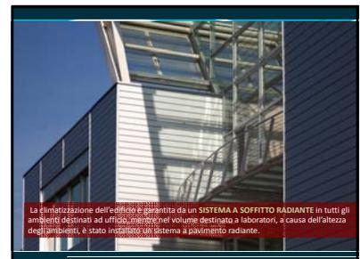
La realizzazione dell'edificio è garantita da un **SISTEMA A SORBITTO RADIANTE** in tutti gli ambienti destinati ad ufficio, mentre il volume destinato a laboratorio, a causa dell'altezza degli ambienti, è stato installato un sistema a pavimento radiante.
