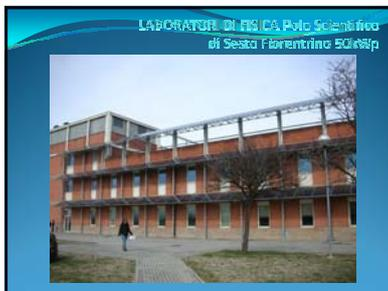
L'edificio oggetto dell'intervento è suddiviso in più porzioni con due, tre o quattro piani fuori terra, disposti a formare due quadrilateri che racchiudono due cortili interni. Sopra la copertura delle porzioni di edificio di due e tre piani sono presenti delle strutture metalliche con altezza pari ad un piano, con funzione estetica; le porzioni di edificio di quattro piani sono disposte ai vertici dei quadrilateri come torrette.
