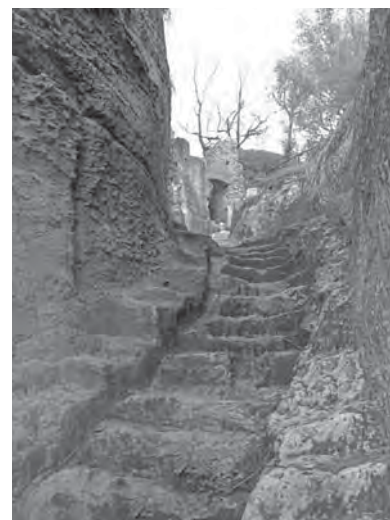
(Pic. 82) Staircase excavated from the rock, (N. Barbalace).
