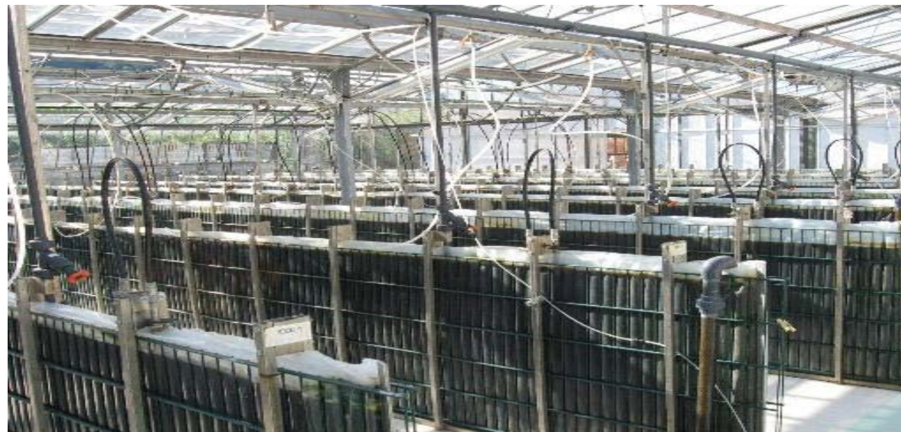
Figura. 7.2A - Collocazione geografica e visione del sito (in alto) ed impianto pilota attivo di Archimede srl (in basso).
