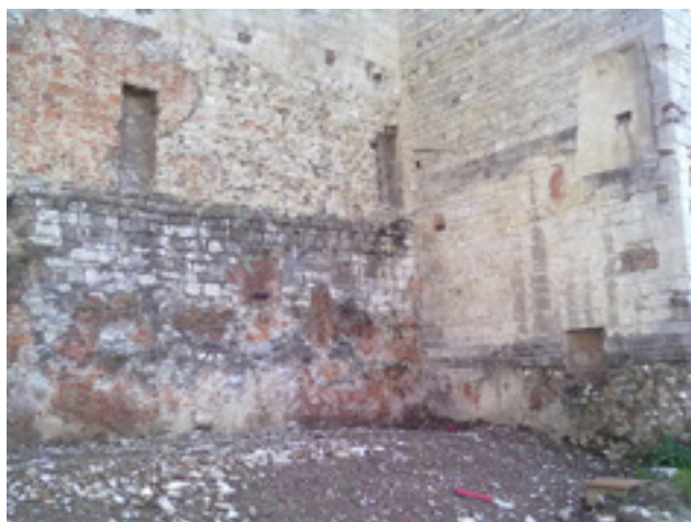
32. La torre rompitrattra. Si noti la pezzatura muraria: a sinistra la parte inferiore della cortina analoga alla torre per dimensioni e filari dei conci. L'asportazione del paramento mette in evidenza l'addossamento della cortina
