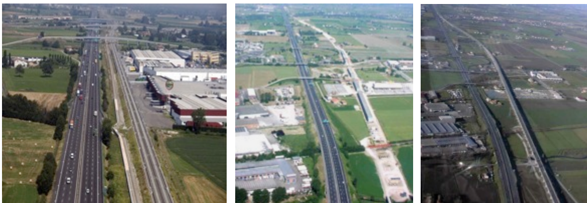
Fascio infrastrutturale della nuova direttrice A1 - TAV nel paesaggio di margine est-ovest del quadrante nord di Parma
