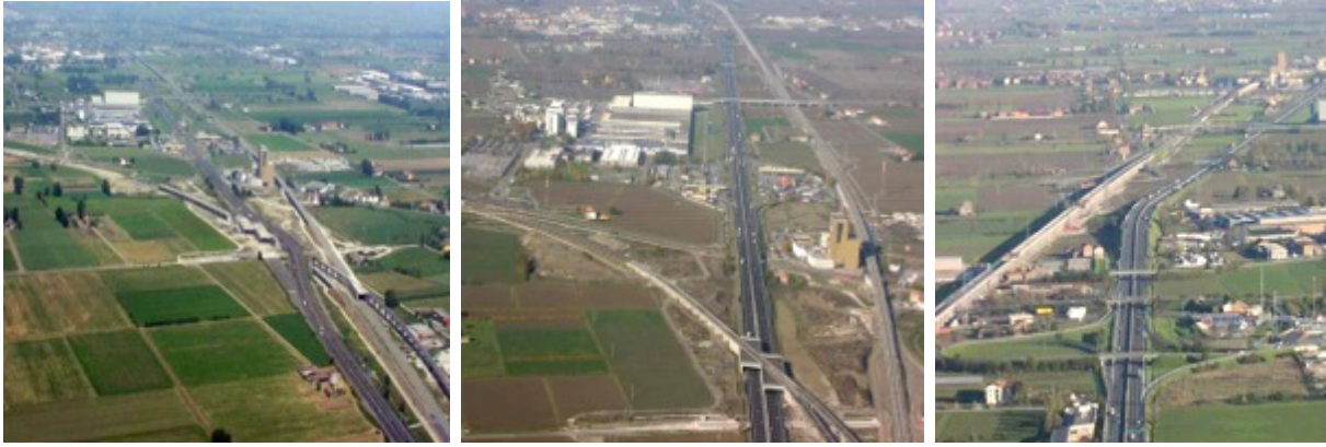
Il fascio infrastrutturale A1/TAV e involucri di interconnessioni con la città di Parma (quadrante NE, località Chiozzola, 2007/08)
