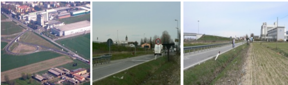
Nuovo svincolo per nuova tangenziale in variante al tracciato della strada Asolana nel paesaggio di San Polo di Torriale.
