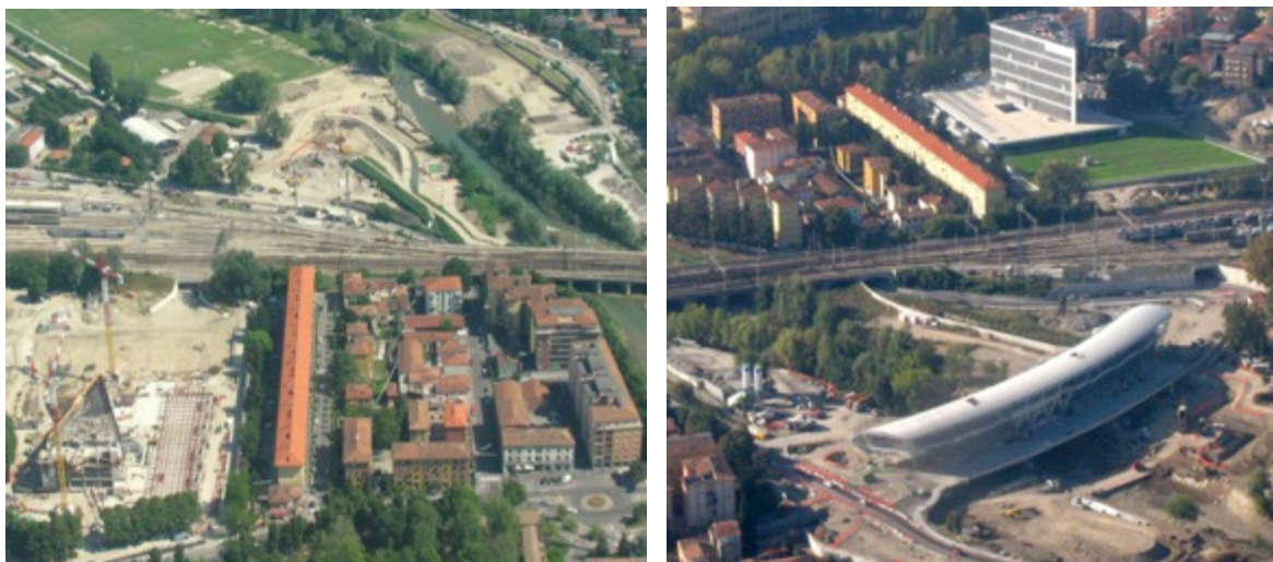
Il nuovo sistema di "non relazioni" creato dalla nuova Sede Efsa e dal Ponte Nord nel paesaggio urbano di Parma a nord della Via Emilia in prossimità del torrente Parma.
