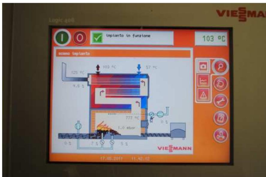
Foto 6. Display per il controllo del funzionamento di una delle caldaie Mawera installate nella centrale termica di Vallombrosa.
