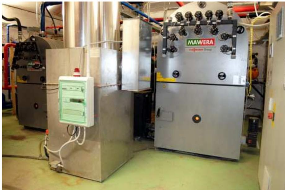
Foto 4. Centrale di teleriscaldamento a cippato di Vallombrosa.
