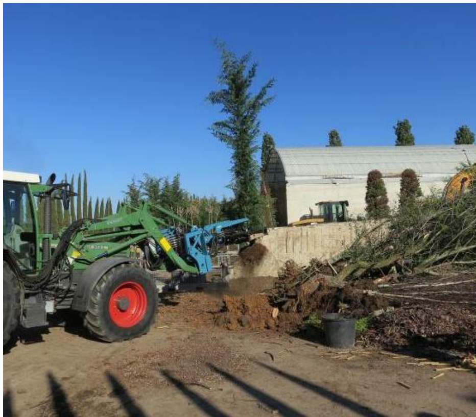
Fig. 3.6 - Cantieri allestiti per la gestione degli scarti verdi: a sinistra piccolo mezzo cingolato allestito con pinza "Andreucci; sulla destra trattore con pinza vibrante della ditta A. Spedo.
