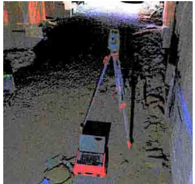
La stazione totale scansionata dal laser scanner in una nuvola di punti dei rilievi digitali. A sottolineare l'importanza del rilievo topografico come supporto a quello laser scanner eseguiti parallelamente.
