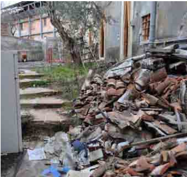
Il contesto post-sisma può presentare diversi ostacoli alle operazioni di rilievo; le macerie, se non ancora rimosse, possono occludere l'attacco a terra degli edifici.
