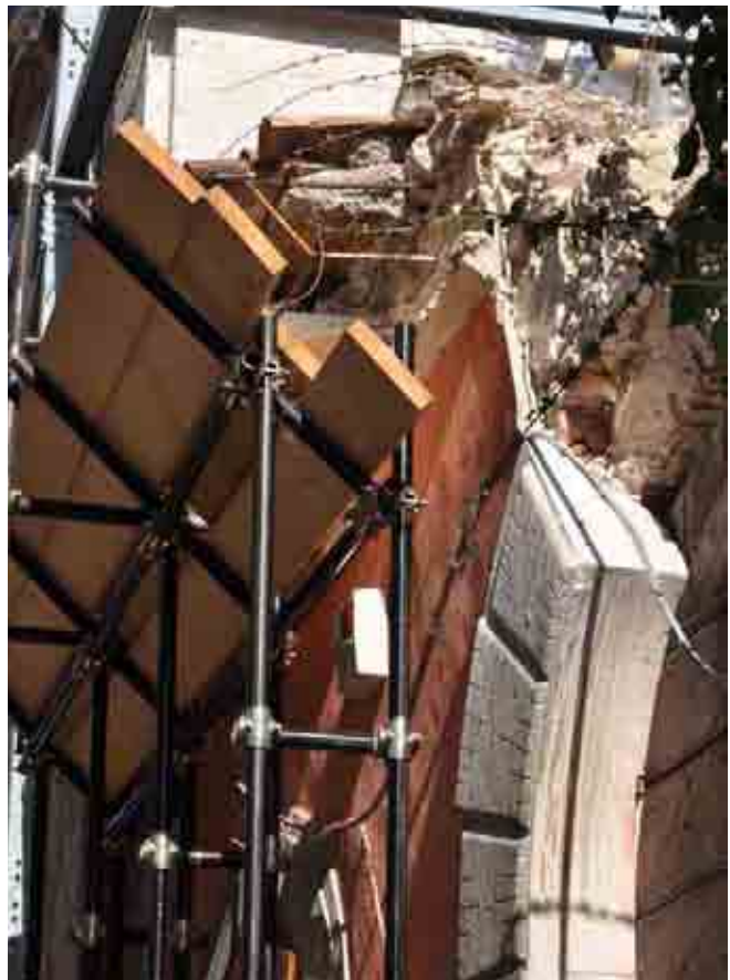
In questa foto viene evidenziata l'esigenza, ai fini della successiva restituzione grafica, di documentare dettagli architettonici, costruttivi, o riferiti a dissesti, che sono occlusi al rilievo strumentale ad esempio da elementi per la messa in sicurezza.
