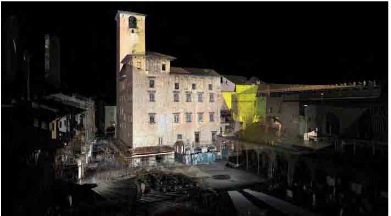
Una vista della nuvola di punti relativa al rilievo del 2012. In alto: la versione secondo il dato originale acquisito, in basso: la versione visualizzata con i colori reali dei materiali grazie all'inserimento nella nuvola di punti delle foto orbitali.
