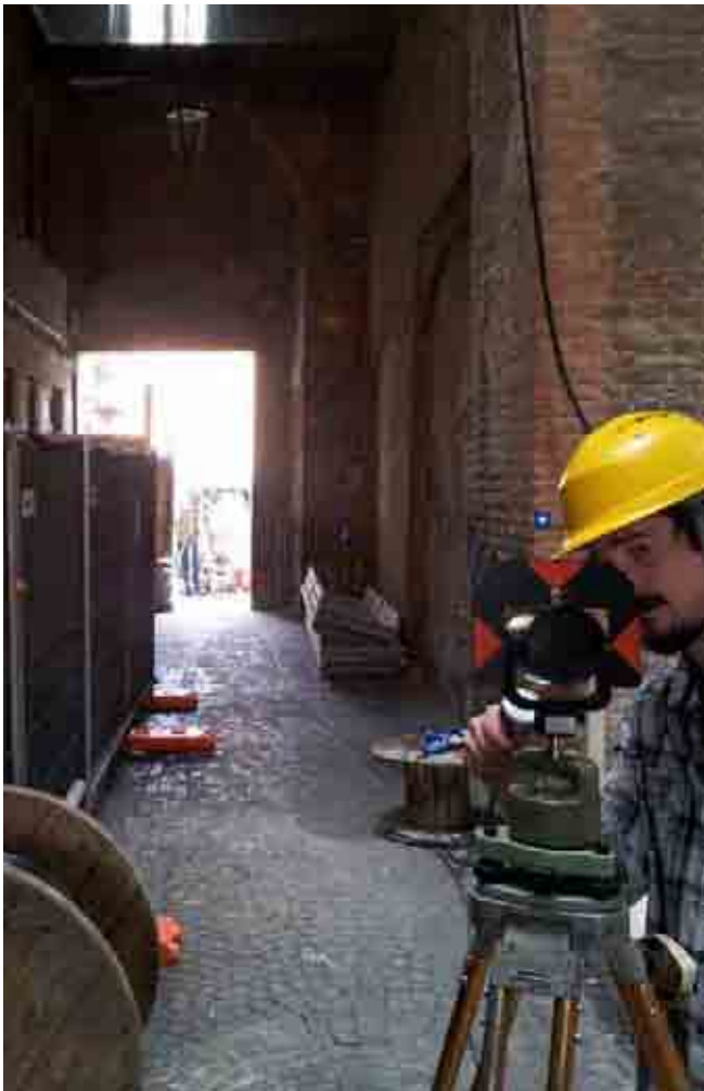
Nelle immagini della pagina precedente: un momento del rilievo topografico effettuato contestualmente a quello laser scanner del 2012. I target presenti in sito dal rilievo del 2007.
