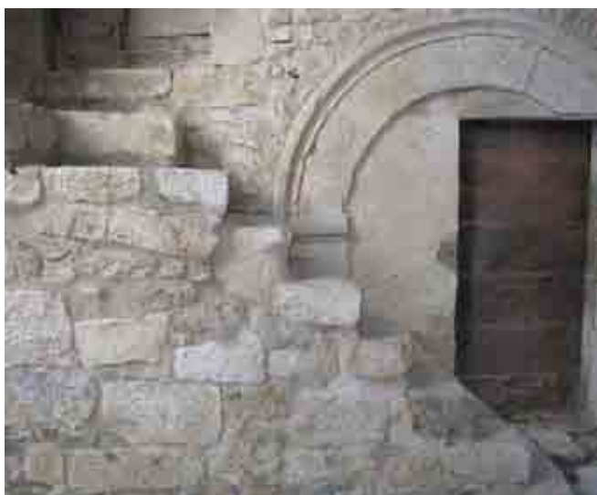
Dettaglio e vista interna al Castello di Beffi.
