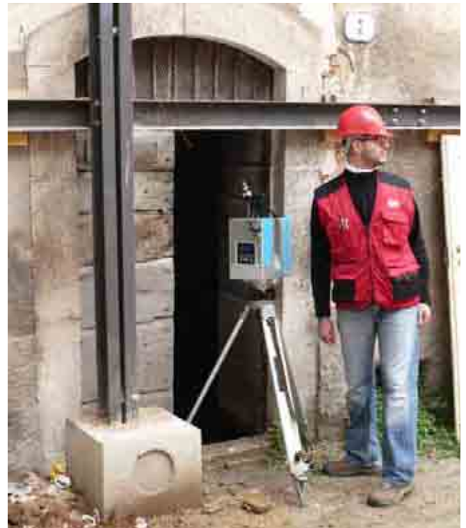
Nella foto sopra: un momento del rilievo laser scanner nel centro storico di L'Aquila.
