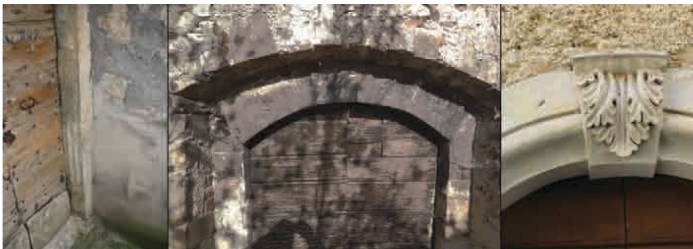
Esempi di pietra di migliore qualità o di elementi lapidei di riuso provenienti da zone archeologiche limitrofe, utilizzati per dettagli decorativi delle architetture di questi centri storici generalmente "povere".
