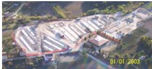
foto aerea delle aree M.A.P. di Castelnuovo di San Pio delle Camere (AQ) in fase di realizzazione
