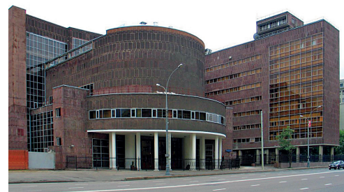
Figg. 4, 5 Le Corbusier, Centrosoyuz, Mosca, Russia, 1928 - 1933. Il concetto essenziale della facciata a doppia pelle per la prima volta esplorato e testato da Le Corbusier. L'idea, che egli chiamò "mur neutralisant", ha coinvolto l'inserimento di tubi di riscaldamento/raffreddamento tra gli strati di vetro di grandi dimensioni.
