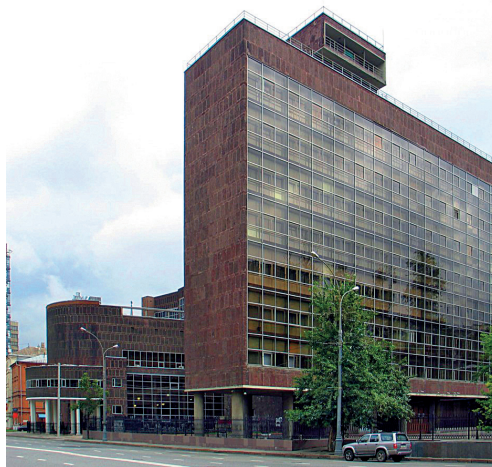
Figg. 4, 5 Le Corbusier, Centrosoyuz, Mosca, Russia, 1928 - 1933. Il concetto essenziale della facciata a doppia pelle per la prima volta esplorato e testato da Le Corbusier. L'idea, che egli chiamò "mur neutralisant", ha coinvolto l'inserimento di tubi di riscaldamento/raffreddamento tra gli strati di vetro di grandi dimensioni.
